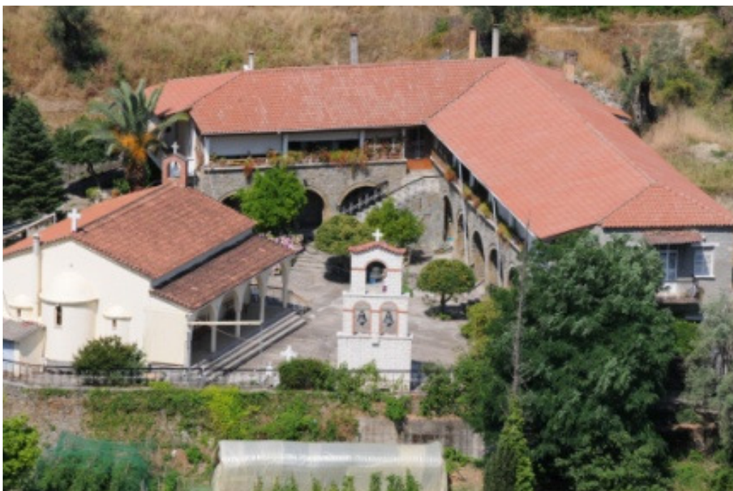
Εικόνα 17. Άποψη της Μονής της Γενέσεως της Θεοτόκου ( https://iaitoloakarnania.gr/ )
