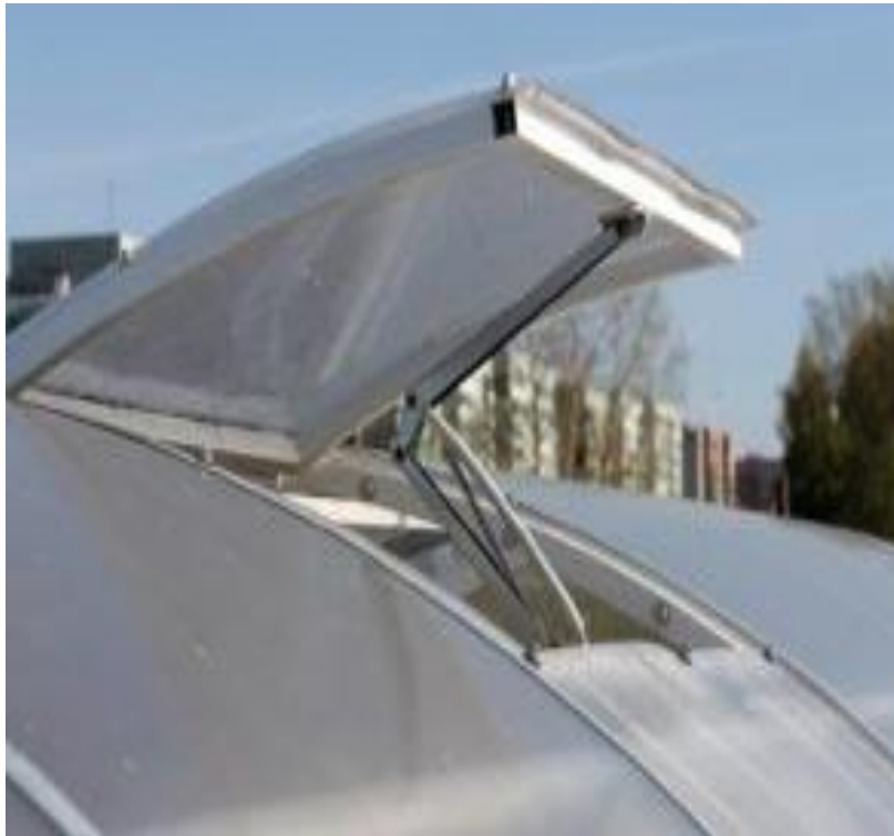
Εικόνα 5.7 : Ηλεκτρικό Παράθυρο Θερμοκηπίου
