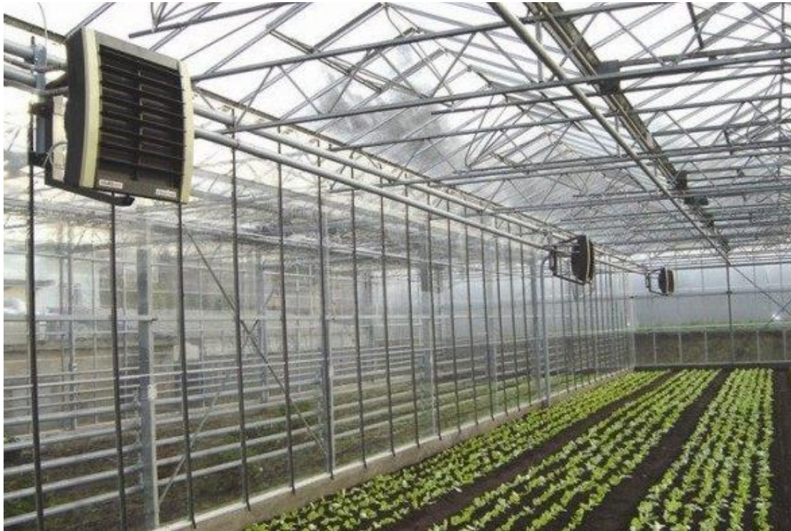
Εικόνα 5.5 : Θερμαντικά Σώματα
