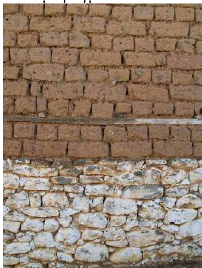
Σχήμα 1.7 Χαρακτηριστικό παράδειγμα παραδοσιακής ωμοπλινθοδομής ( http://5a.arch.ntua.gr/project/15571/15806 )
