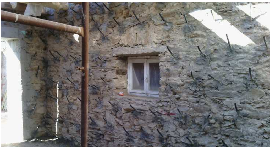
Σχήμα 2.14 Τσιμεντοενέσεις σε τοιχοποιία ( https://anastilotiki-volou.gr/portfolio-posts/tsimenteneseis/ )
