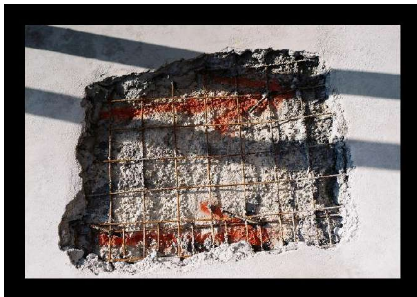
Σχήμα 2.15 Οπλισμένο επίχρισμα ( https://www.michanikos.gr )
