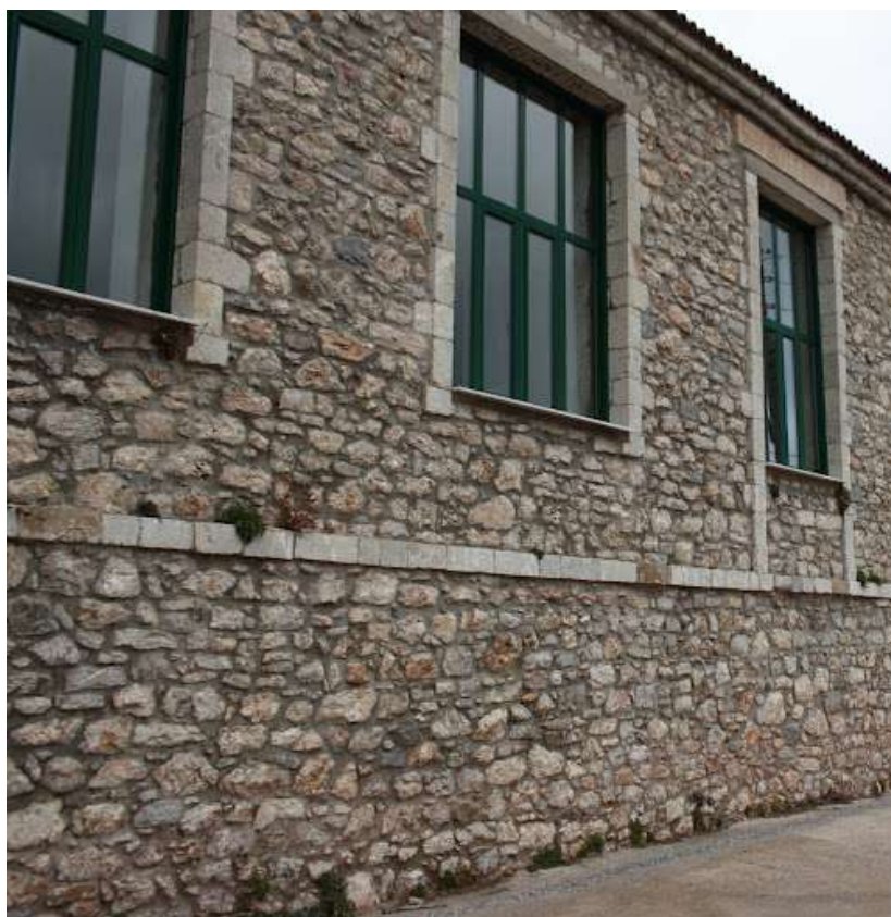
Σχήμα 1.6 Χαρακτηριστική λαξεμένη λιθοδομή.
