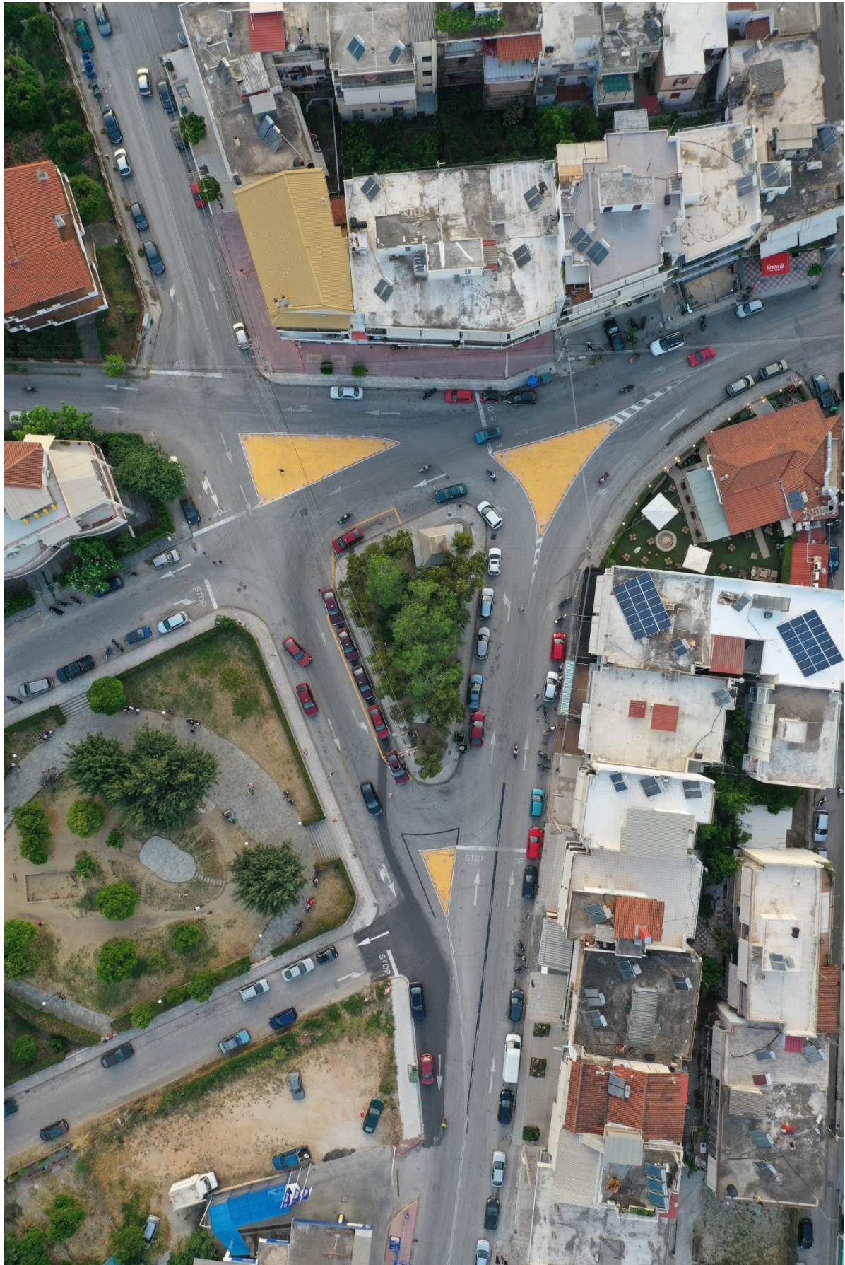
Εικόνα 17. Αεροφωτογραφία από drone (γ)
