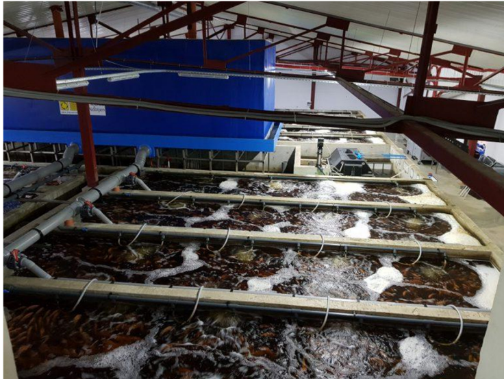
Εικόνα 2.4: Biotower (μπλε δεξαμενή) με τα φίλτρα στο εσωτερικό. (Πηγή: www.aquacultureid.com )
