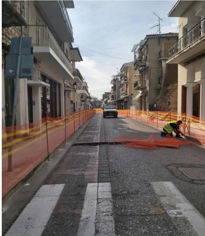
Εικόνα 28 Εργασίες περίφραξης στην οδό Ν. Μπότσαρη
