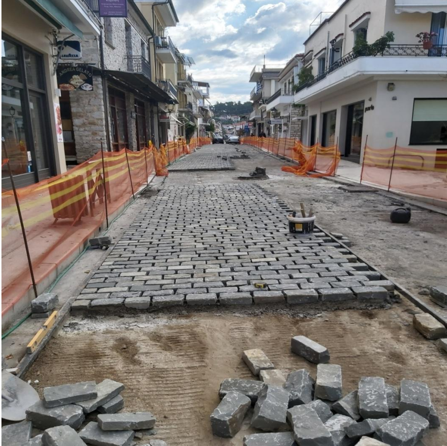
Εικόνα 25 Εφαρμογή κυβόλιθων οδοποιίας στην Ν. Μπότσαρη
