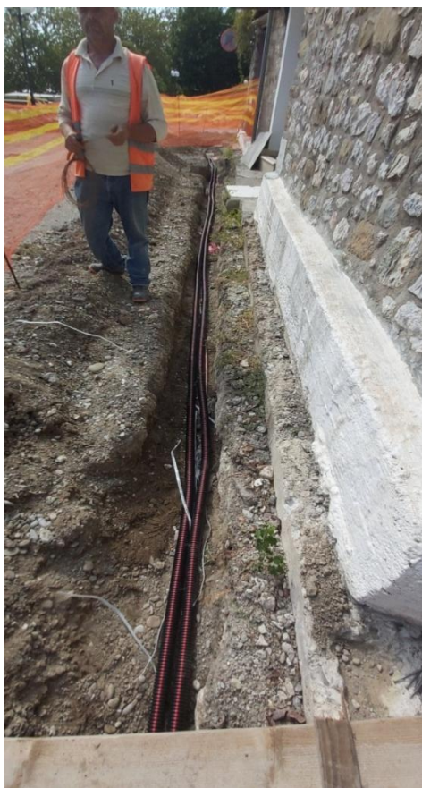
Εικόνα 33 Προετοιμασία τοποθέτησης καλωδίων για οδοφωτισμό
