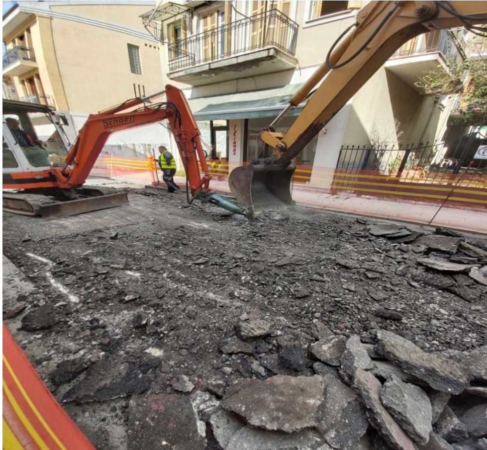
Εικόνα 23 Αποψίλωση ασφαλτοτάπητα στην οδό Ν. Μπότσαρη
