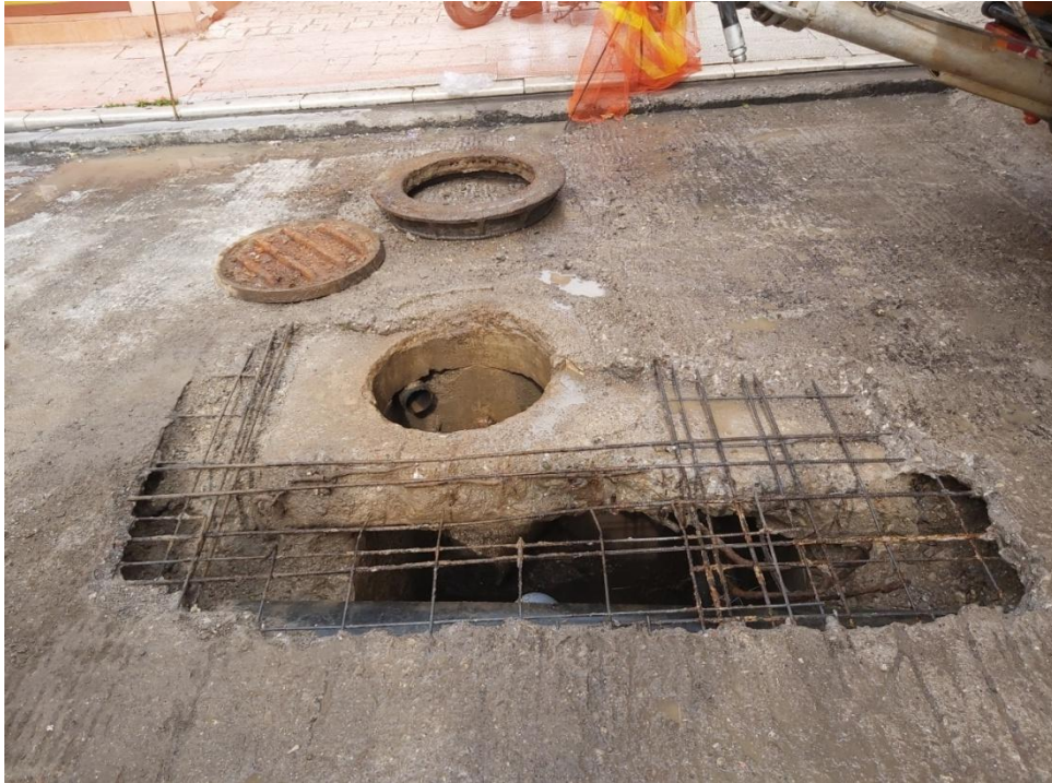
Εικόνα 31 Κατασκευή επισκέψιμου φρεατίου
