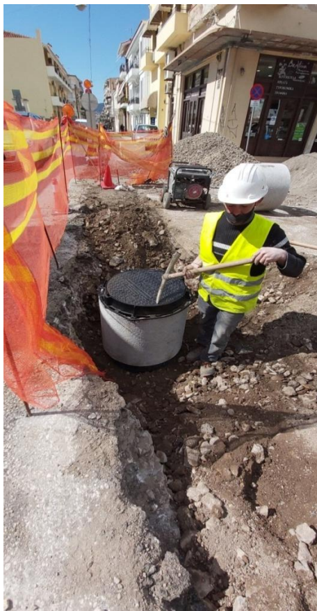
Εικόνα 32 Κατασκευή φρεατίου ακαθάρτων στην Ι. Τζαβέλα
