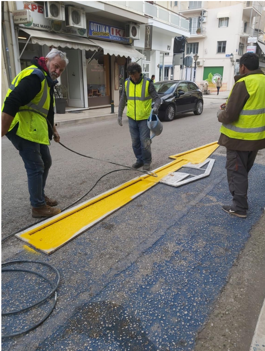
Εικόνα 30 Εργασίες διαγράμμισης οδοστρώματος στην οδό Ι. Τζαβέλα
