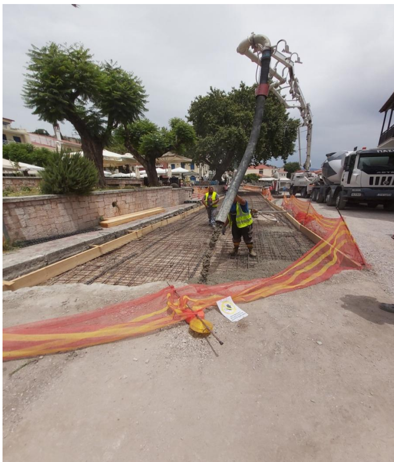
Εικόνα 24 Σκυροδέτηση βάσης οδοποιίας στη οδό Ν. Μπότσαρη
