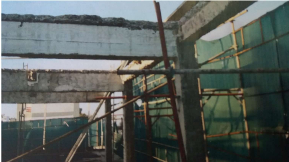
Εικόνα 23. Άποψη κτηρίου πριν τις ενισχύσεις του 2010 – Γ' όροφος – Δώμα. (Πηγή: Αρχείο Υ.ΔΟΜ. Πατρέων)
