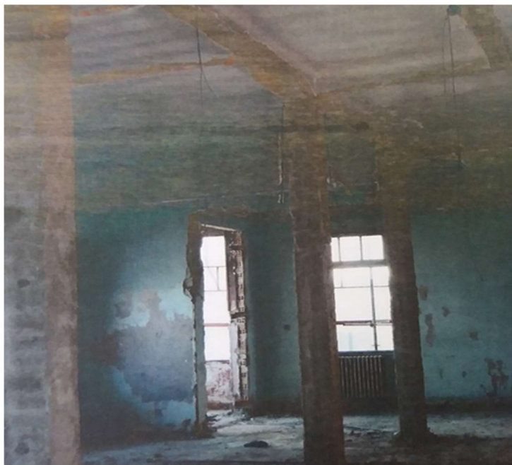
Εικόνα 10. Άποψη κτηρίου πριν τις ενισχύσεις του 2010 – Β' όροφος. (Πηγή: Αρχείο Υ.ΔΟΜ. Πατρέων)
