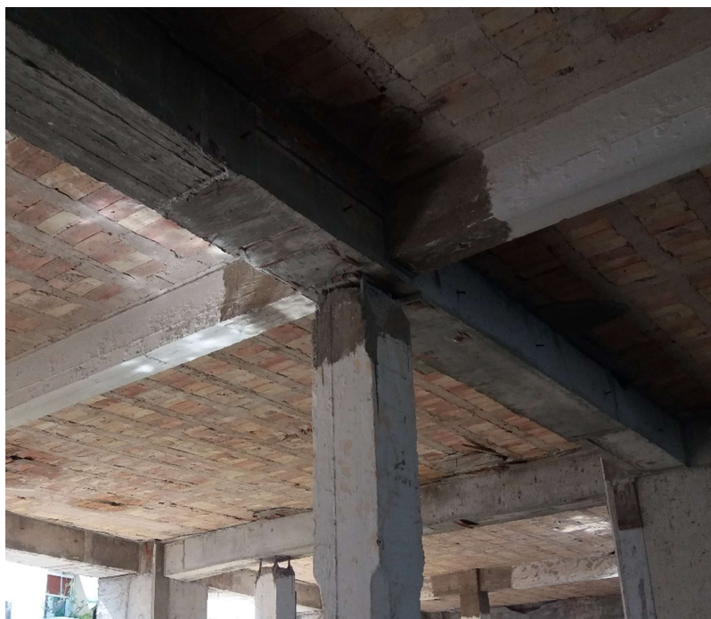
Εικόνα 20. Νέα δοκός. Παλαιό υποστύλωμα και παλαιά δοκός προς αφαίρεση στον Β' όροφο του Κτηρίου Β. (Πηγή: Προσωπικό αρχείο)
