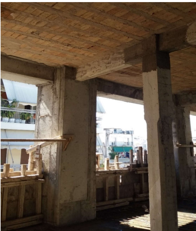
Εικόνα 19. Νέο υποστύλωμα μετά την ενίσχυση, παλαιό προς αφαίρεση και διαδοκιδωτή πλάκα στον Β' όροφο του Κτηρίου Β. (Πηγή: Προσωπικό αρχείο)
