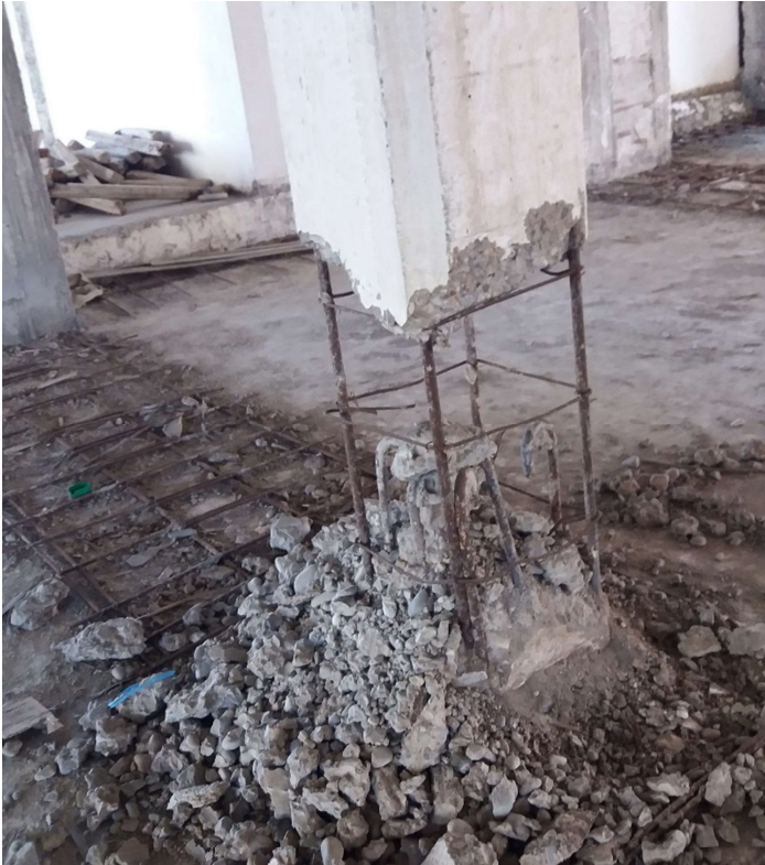
Εικόνα 16. Παλιό υποστύλωμα του Α' ορόφου του κτηρίου Β προς αφαίρεση. (Πηγή: Προσωπικό αρχείο)
