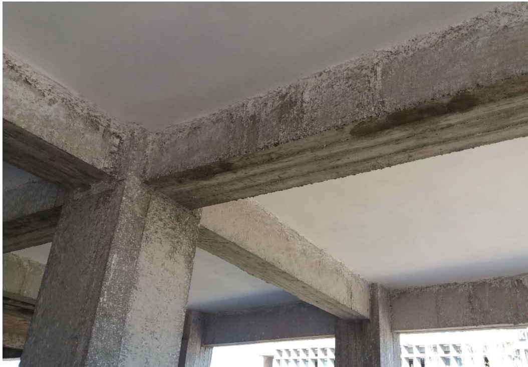
Εικόνα 22. Δοκοί και υποστυλώματα του Β' ορόφου του κτηρίου Α που έχουν ενισχυθεί. (Πηγή: Προσωπικό αρχείο)
