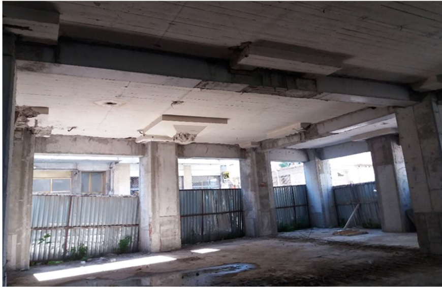
Εικόνα 15. Άποψη ισογείου από το κτήριο Β με μυκητοειδής πλάκες. (Πηγή: Προσωπικό αρχείο)
