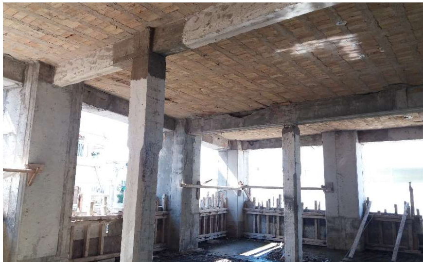
Εικόνα 16. Άποψη διαδοκιδωτής πλάκας και υποστυλωμάτων προς αφαίρεση στον Α' όροφο του Κτηρίου Β. (Πηγή: Προσωπικό αρχείο)
