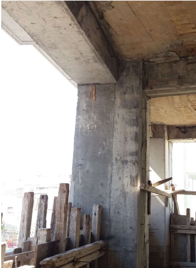
Εικόνα 18. Νέο υποστύλωμα και δοκοί στον Β' όροφο του κτηρίου Β μετά την επέκτασή τους. (Πηγή: Προσωπικό αρχείο)
