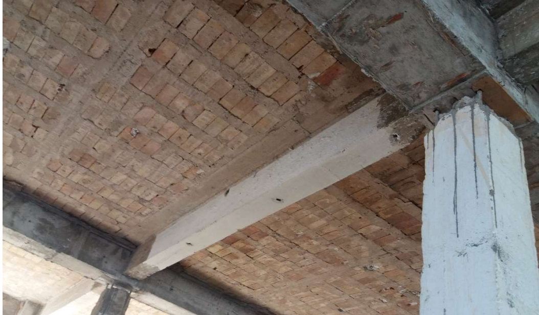
Εικόνα 21. Παλαιά δοκός και υποστύλωμα προς αφαίρεση κάθετα σε αυτά που έχουν ενισχυθεί στον Β' όροφο του Κτηρίου Α. (Πηγή: Προσωπικό αρχείο)
