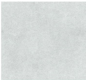
Εικόνα 66. Σοβάς λευκής απόχρωσης σε εσωτερικούς και εξ. Χώρους.
