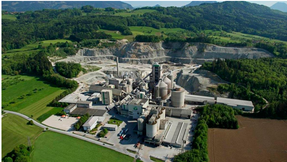
Εικόνα 66: Βιομηχανία Τσιμέντου στο Rohrdorf της Γερμανίας με ανάκτηση θερμότητας των αερίων για παραγωγής ηλεκτρικής. [60]
