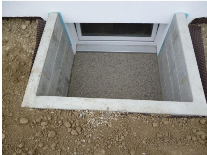
Σχήμα 2.8 Παράδειγμα υπόσκαφου τμήματος (cour'anglese).
