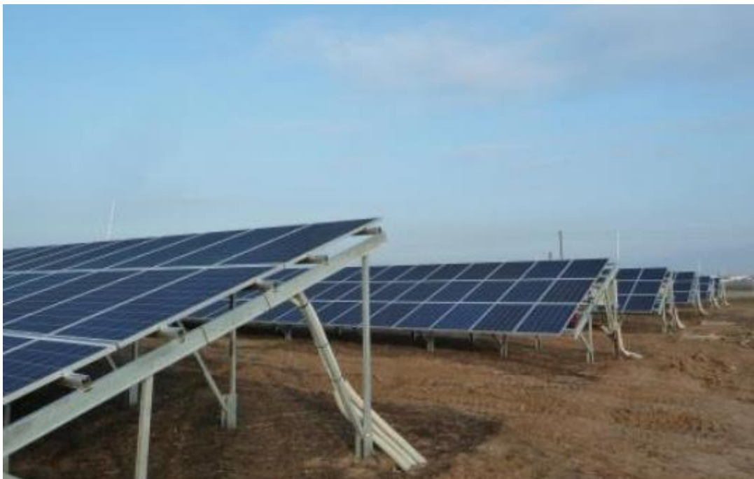
Εικόνα 5.4 παράδειγμα διάταξης 3 portrait
