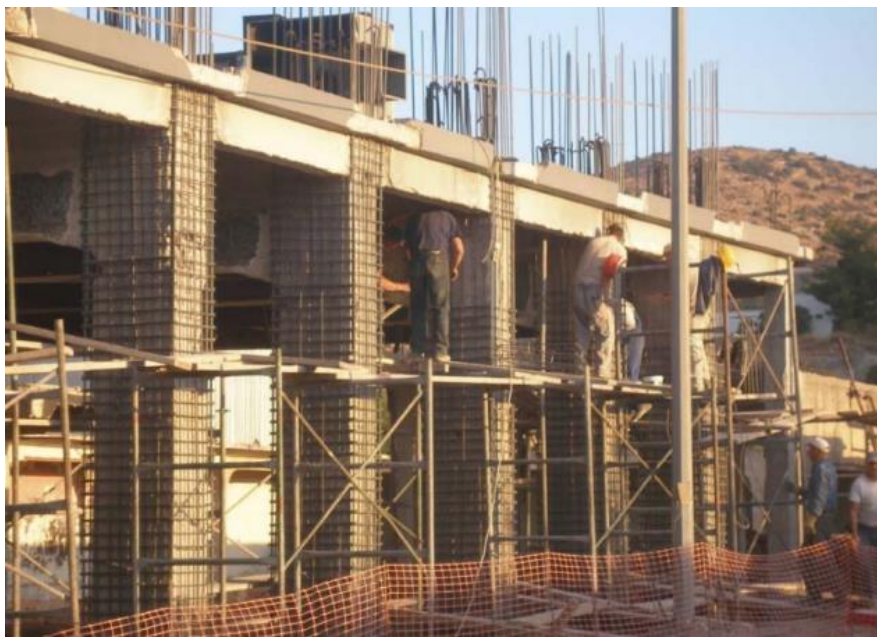
Εικόνα 41 Εφαρμογή μανδύα οπλισμένου σκυροδέματος. (Μπισκίνης Διονύσιος, Παρουσιάσεις μαθήματος, Πανεπιστήμιο Πελοποννήσου)
