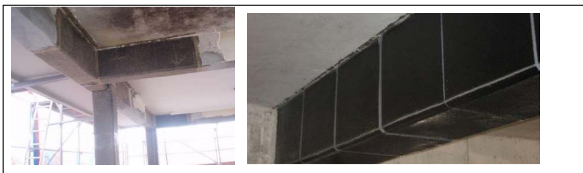
Εικόνα 49 Διατμητική ενίσχυση δοκών με FRPs. (Μπισκίνης Διονύσιος, Παρουσιάσεις μαθήματος, Πανεπιστήμιο Πελοποννήσου)
