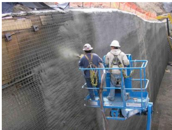
Εικόνα 40 Χρήση Εκτοξευόμενου Σκυροδέματος χειροκίνητα ελεγχόμενη. (Μπισκίνης Διονύσιος, Παρουσιάσεις μαθήματος, Πανεπιστήμιο Πελοποννήσου)
