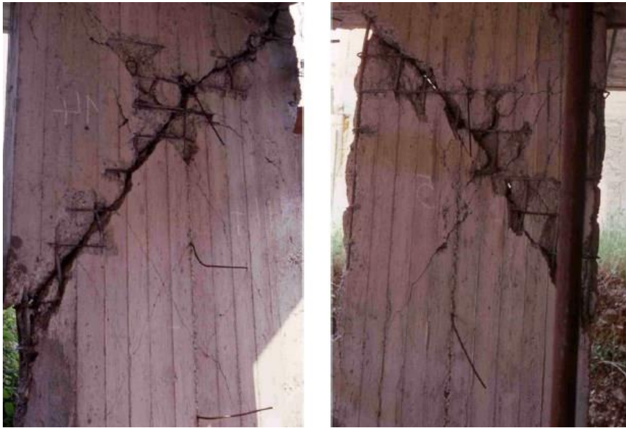
Εικόνα 12 Διατμητική αστοχία σε λοξό εφελκυσμό. (Μπισκίνης Διονύσιος, Παρουσιάσεις μαθήματος, Πανεπιστήμιο Πελοποννήσου).
