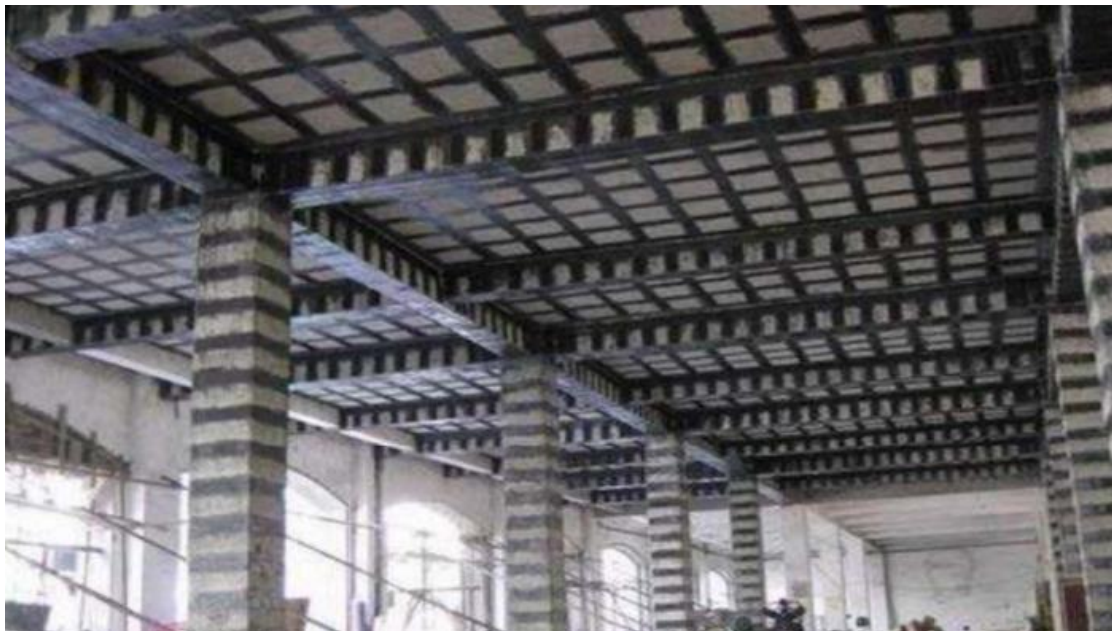
Εικόνα 48 Καμπτική και διατμητική ενίσχυση με ινοπλισμένα πολυμερή. . (Μπισκίνης Διονύσιος, Παρουσιάσεις μαθήματος, Πανεπιστήμιο Πελοποννήσου)
