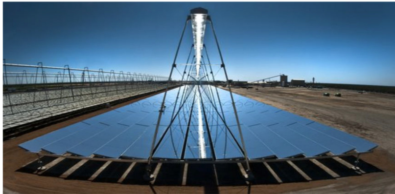
Σχήμα 2.7: Γραμμικό σύστημα κατόπτρων Fresnel (Πηγή: wileyonlinelibrary.com)
