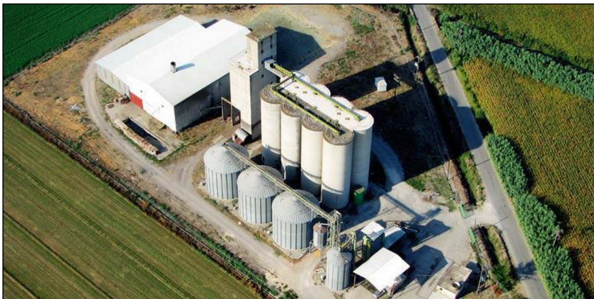
Σχήμα 3.1: Εργοστάσιο επεξεργασίας μηδικής
