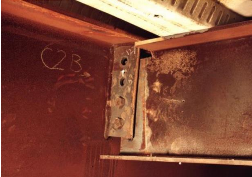
Εικόνα 24: Θράυση Κοχλιών Σύνδεσης
