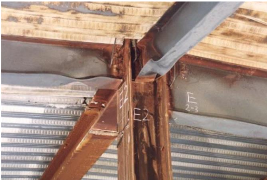
Εικόνα 23: Τοπικός Λυγισμός Ελεύθερων Κάτω Πελμάτων Δοκών
