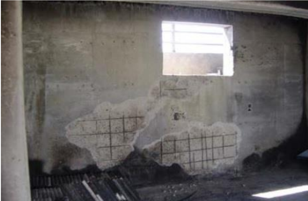
Εικόνα 17: Αποφλοιώση Σκυροδέματος
