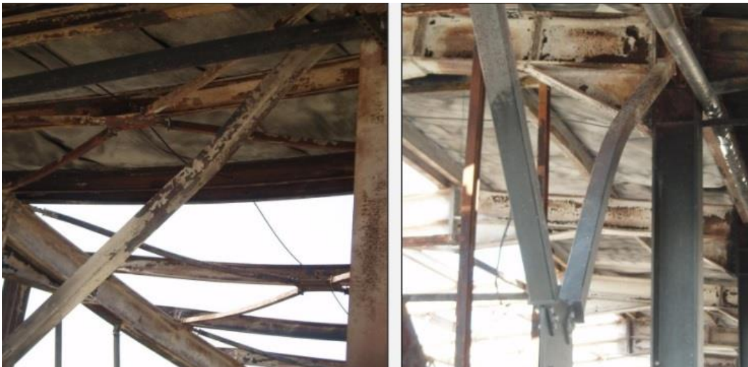
Εικόνα 21: Λυγισμός Διαγώνιων Ράβδων Χιαστί Συνδέσμων Δυσκαμψίας
