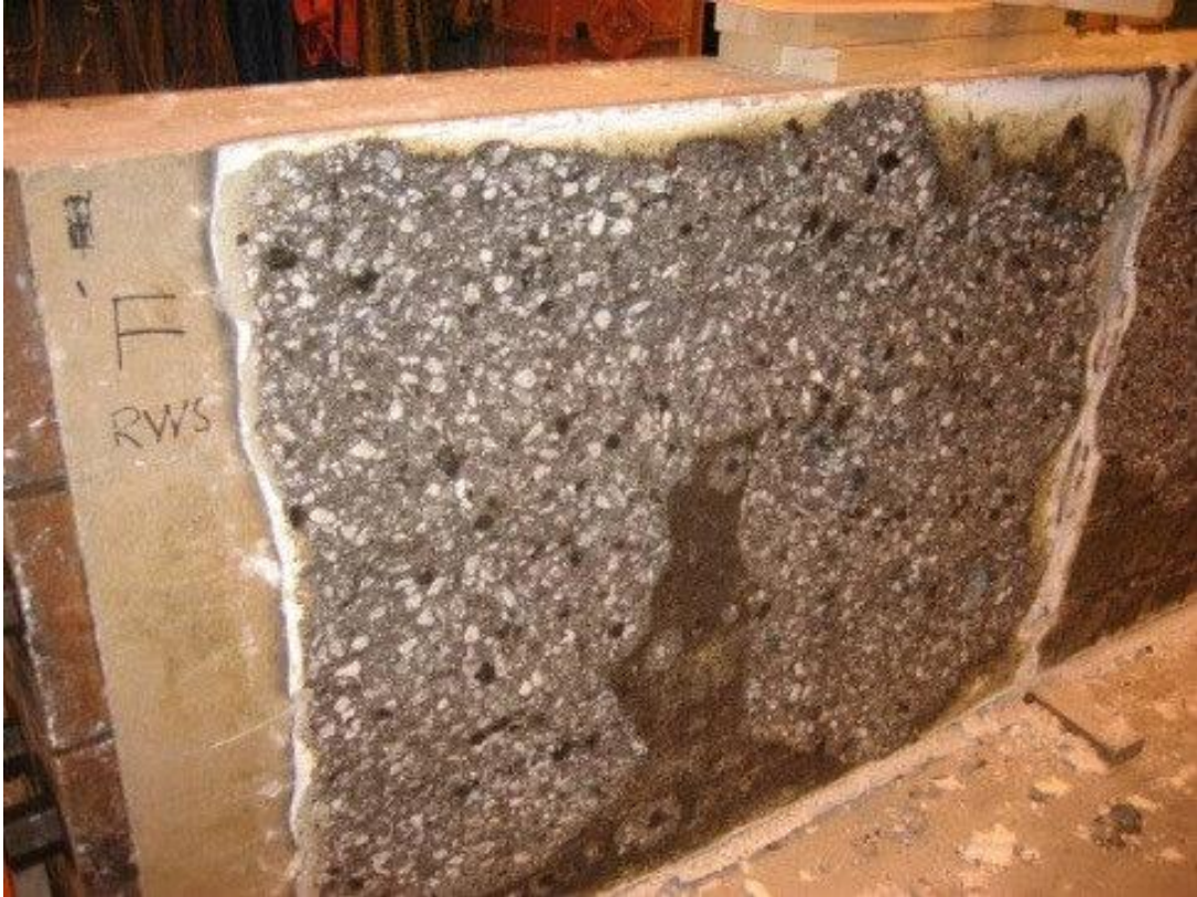
Εικόνα 10: Επιφανειακές Ζημιές Οπλισμένου Σκυροδέματος
