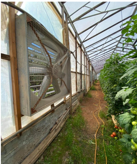
Εικόνα 11: Αερισμός θαλάμων
