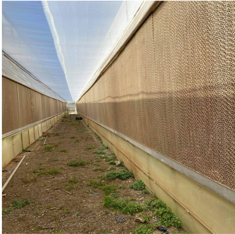
Εικόνα 10: Εξωτερικά οι θάλαμοι με πετροβάμβακα
