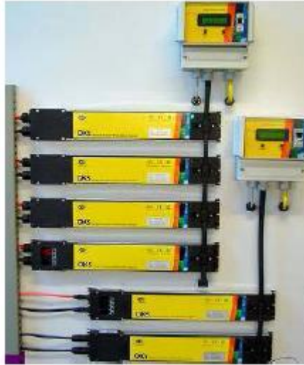
Εικόνα 3.1.4 Αντιστροφείς για ενσωμάτωση σε Φ/Β πάνελ
