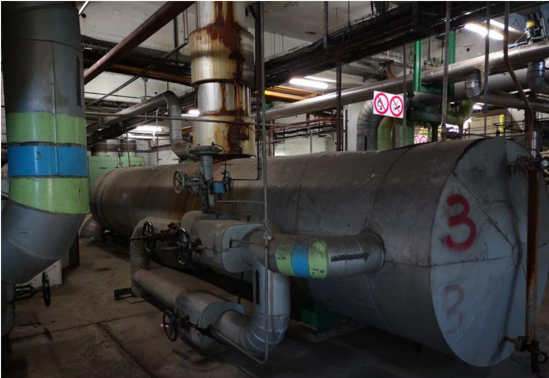
Εικόνα 20: Προθερμαντής Χ.Π ΙΙΙ (Πηγή: ΜΟΝΑΔΑ ΙΙΙ ΜΕΓΑΛΟΠΟΛΗΣ )
