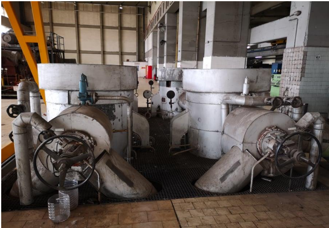
Εικόνα 26: Προθερμαντές 5.1 και 5.2 (Πηγή: ΜΟΝΑΔΑ ΙΙΙ ΜΕΓΑΛΟΠΟΛΗΣ )
