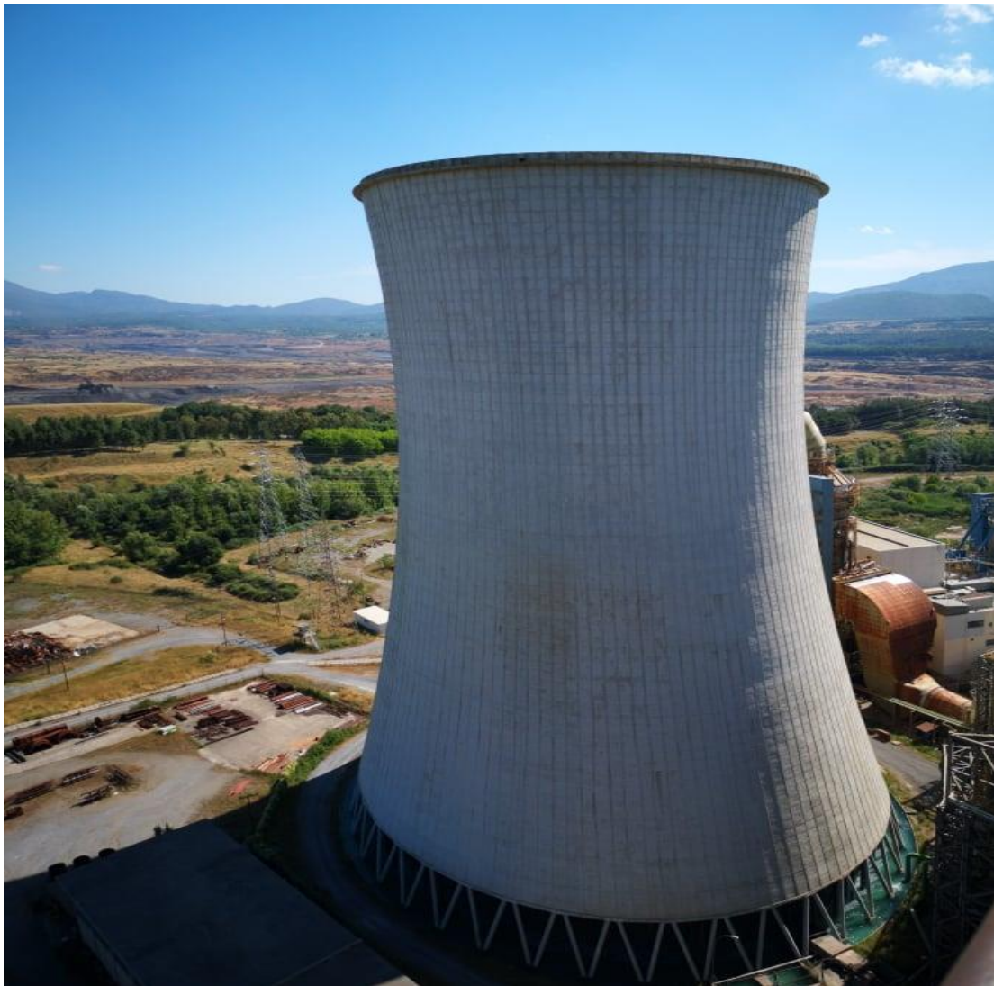
Εικόνα 29: Πύργος ψύξης (Πηγή: ΜΟΝΑΔΑ ΙΙΙ ΜΕΓΑΛΟΠΟΛΗΣ )
