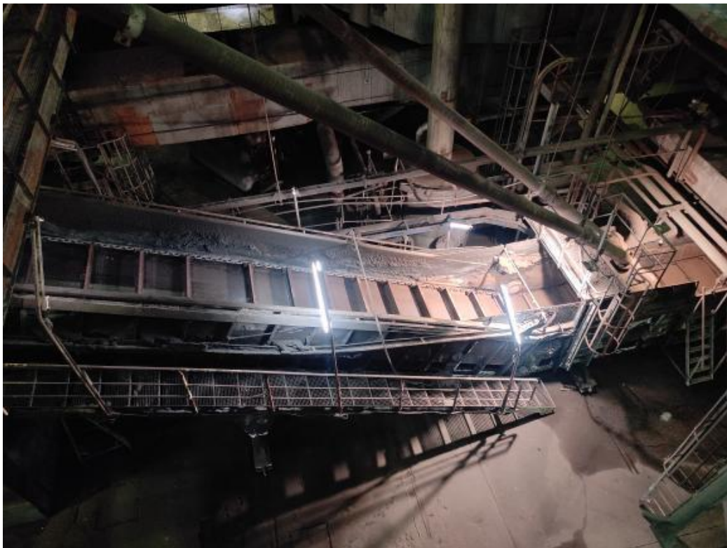
Εικόνα 14: Μεταλλική ταινία απομάκρυνσης υγρής τέφρας (Πηγή: ΜΟΝΑΔΑ ΙΙΙ ΜΕΓΑΛΟΠΟΛΗΣ )
