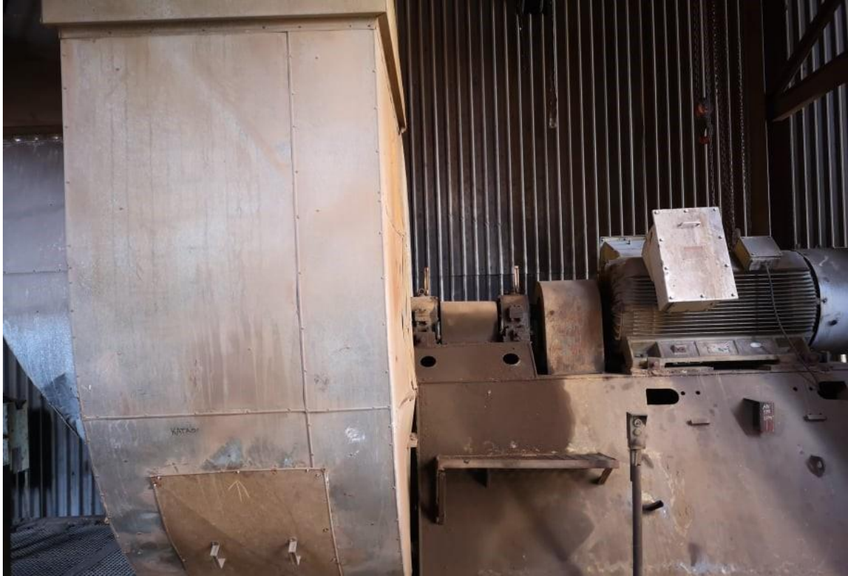
Εικόνα 5: Ανεμιστήρας προωθήσεως (Πηγή: ΜΟΝΑΔΑ ΙΙΙ ΜΕΓΑΛΟΠΟΛΗΣ )
