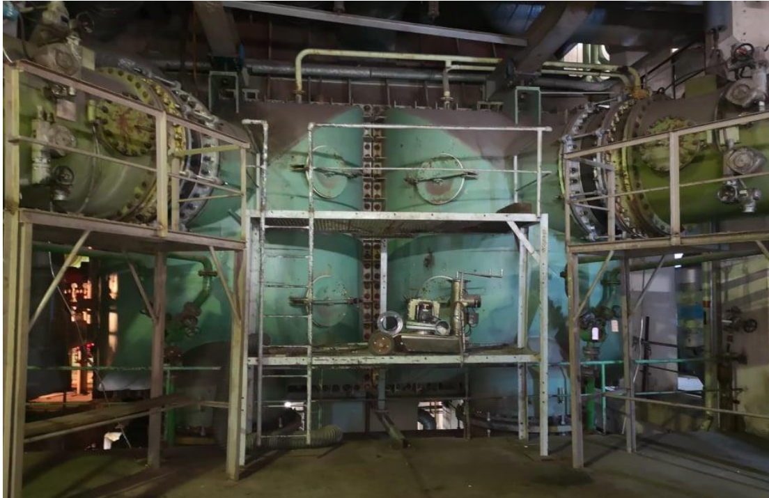
Εικόνα 27: Συμπυκνωτής στρόβιλου (Πηγή: ΜΟΝΑΔΑ ΙΙΙ ΜΕΓΑΛΟΠΟΛΗΣ )
