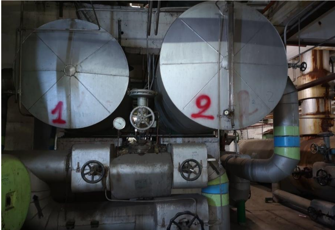
Εικόνα 21: Προθερμαντής Χ.Π Ι και ΙΙ (Πηγή: ΜΟΝΑΔΑ ΙΙΙ ΜΕΓΑΛΟΠΟΛΗΣ )
