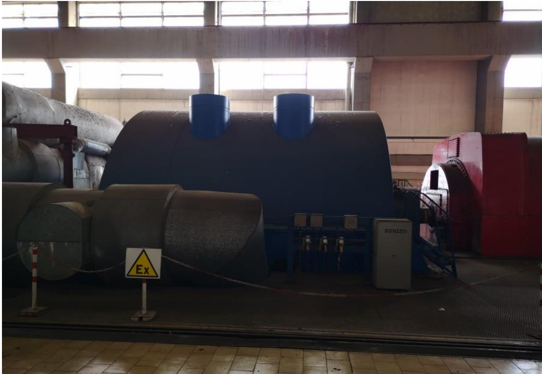
Εικόνα 16: Στρόβιλος Μον III (χαμηλή πίεση)
