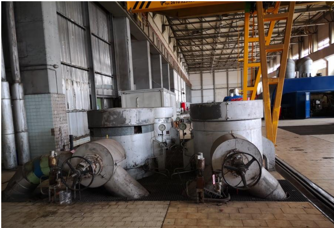
Εικόνα 25: Προθερμαντές 6.1 και 6.2 (Πηγή: ΜΟΝΑΔΑ ΙΙΙ ΜΕΓΑΛΟΠΟΛΗΣ )
