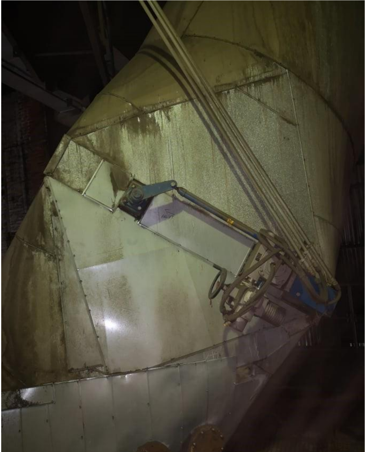
Εικόνα 13: Τάμπερ ταχείας ενεργείας Νο 34 (Πηγή: ΜΟΝΑΔΑ ΙΙΙ ΜΕΓΑΛΟΠΟΛΗΣ )
