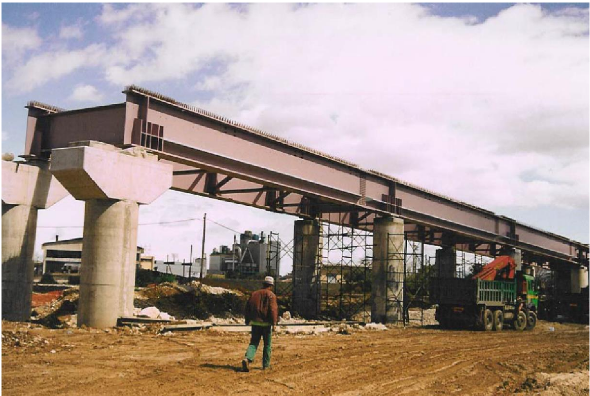
Εικόνα 3.3 Μεταλλικές δοκοί γεφυρών (Ε.Μ.Π.)
