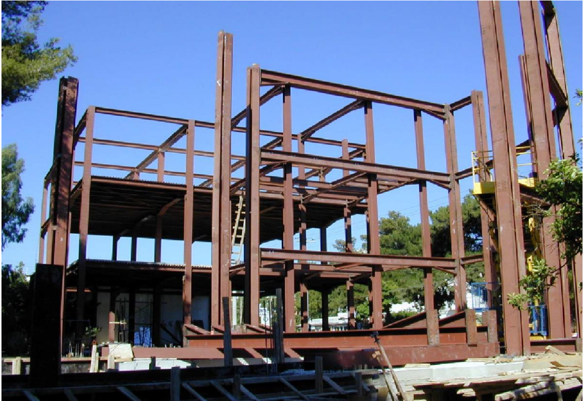
Εικόνα 3.2 Υποστυλώματα και δοκοί πολυώρων κτιρίων (Ε.Μ.Π.)
