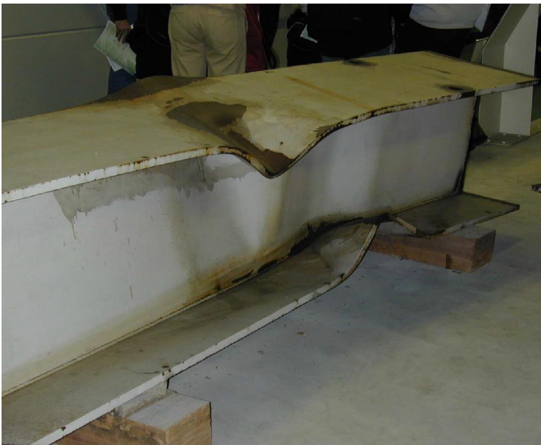
Εικόνα 3.5 Τοπικός λυγισμός μεταλλικής υψίκορμης δοκού (Ε.Μ.Π.)
