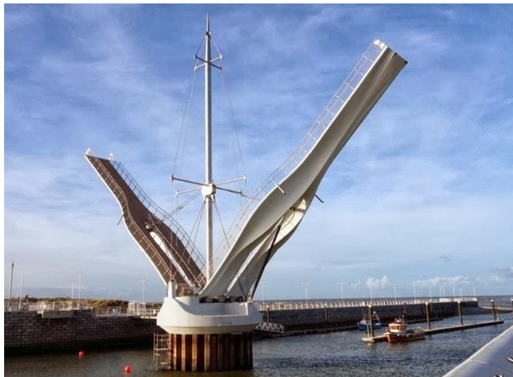
Εικόνα 1.15 Γέφυρα ForydHarbour, Βρετανία [link 15]
