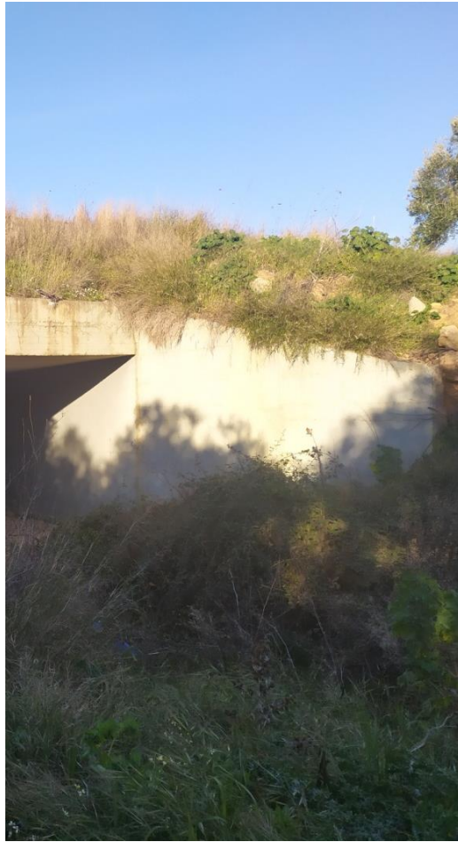
Εικόνα 5.8 Τοίχος Αντιστηρίξεως δεξιάς όψης
