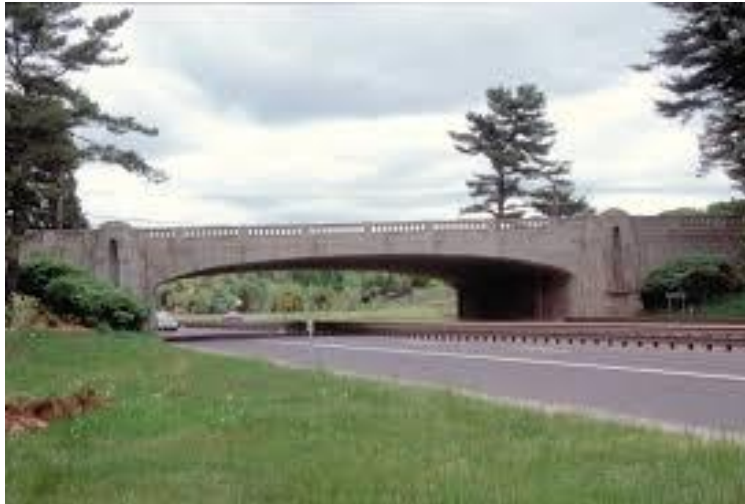
Εικόνα 1.14 Πλαισιοτή γέφυρα, ΗΠΑ [link 14]
