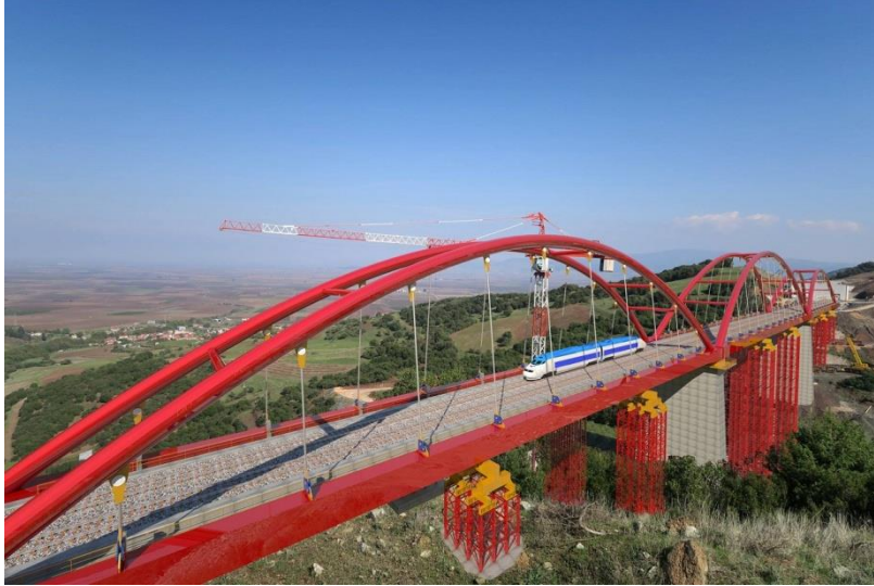
Εικόνα 1.6 Γέφυρα Εκκάρας Δομοκού [link6]
