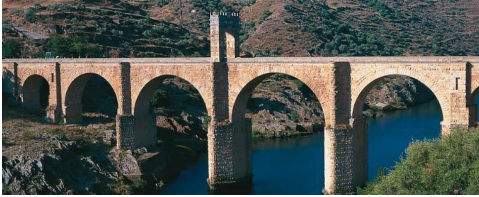
Εικόνα 1.2 Γέφυρα Alcántara [link2]
