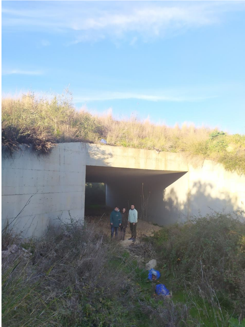
Εικόνα 5.1 Κατεύθυνση οδού προς Μονεμβασιά , δεξιά όψη γέφυρας και οι φοιτητές
