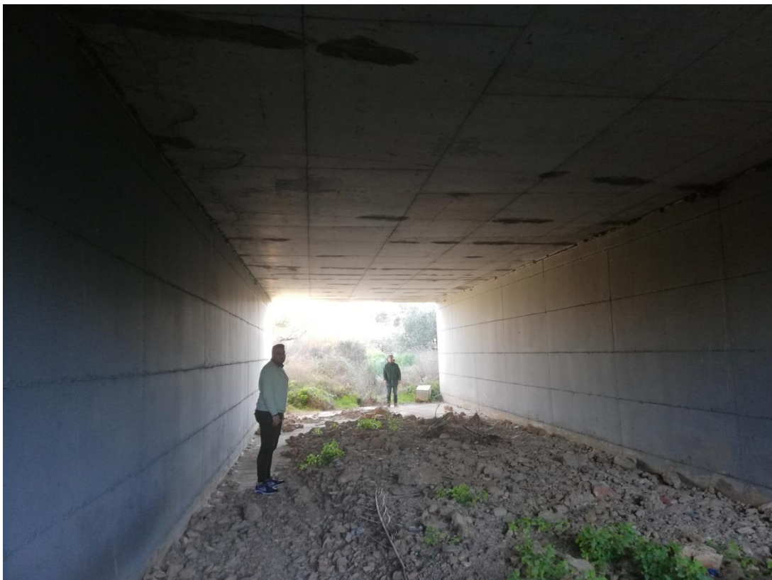
Εικόνα 5.4 Κάτω από την οδό, εντός της γέφυρας και φοιτητές
