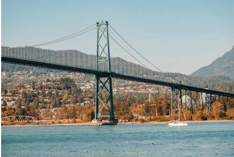
Εικόνα 1.10 Κρεμαστή Γέφυρα, Σικάγο [link 10]
