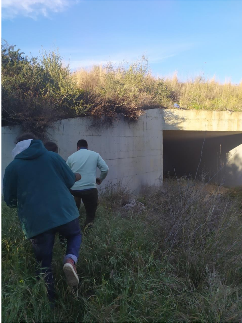
Εικόνα 5.7 Τοίχος Αντιστηρίξεως δεξιάς όψης
