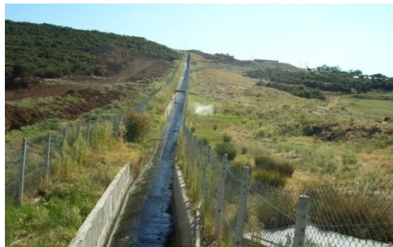
Εικόνα 98: Η ανοικτή ορθογωνική διώρυγα υπερχειλίσης 2,0X2,0 m μήκους 754 m.
