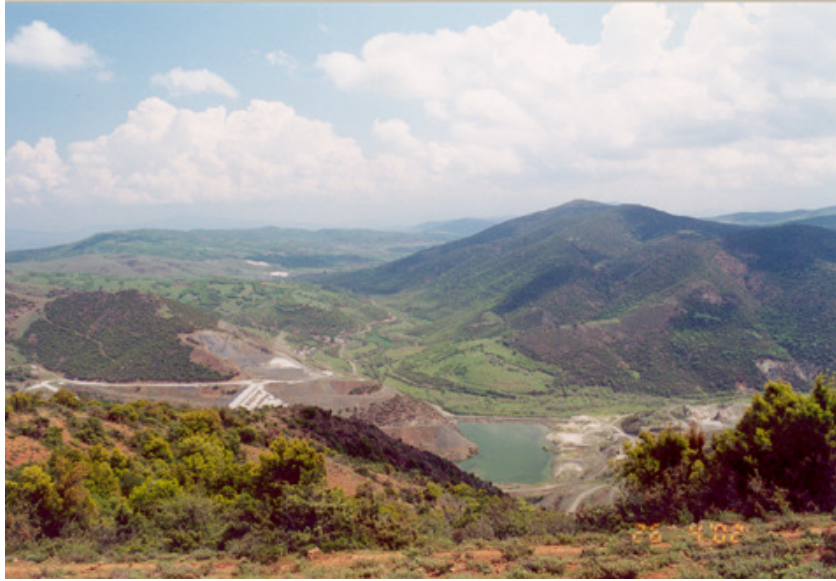
Εικόνα 14: 26/04/2002. Άποψη της περιοχής πριν την έμφραξη. Φαίνονται το πρόφραγμα που δημιουργήθηκε για να συγκρατεί τα νερά των δύο ποταμών, ώστε να είναι δυνατή η κατασκευή του φράγματος.
