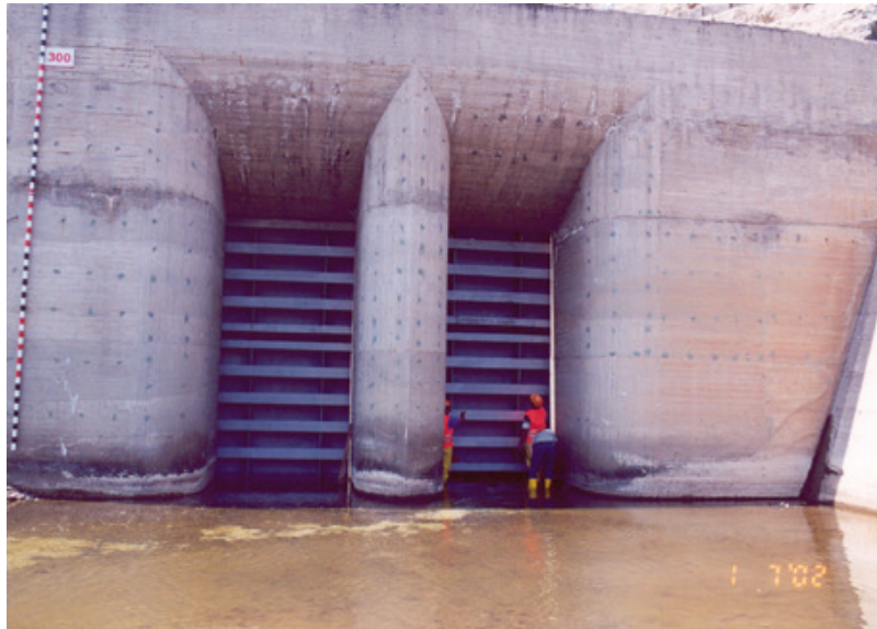
Εικόνα 16: 1/7/2002. ΙΣΤΟΡΙΚΗ ΣΤΙΓΜΗ η έμφραξη της σήραγγας εκτροπής με το κατέβασμα των χαλύβδινων θυρών (υψόμετρο 294 m). Τα νερά των ποταμών έχουν ήδη αρχίσει να συγκεντρώνονται σχηματίζοντας την λίμνη.
