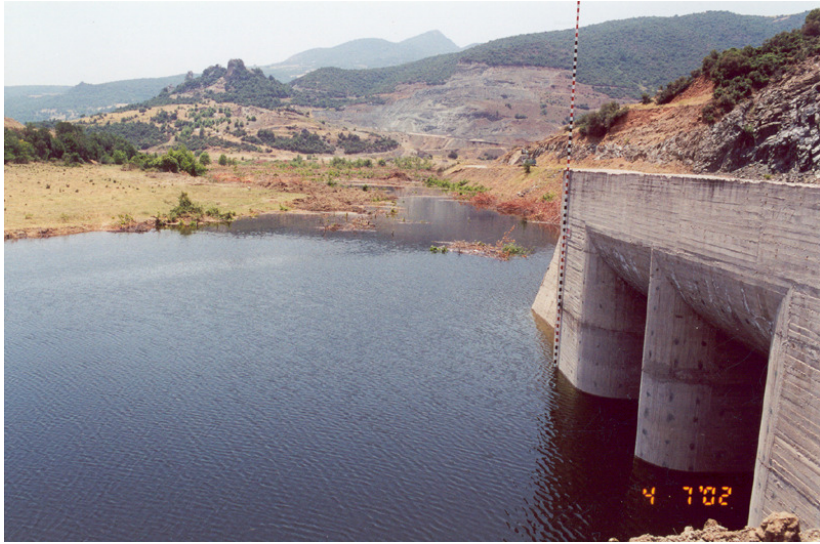
Εικόνα 18: 4/7/2002. Τρεις μέρες αργότερα αρχίζει να σχηματίζεται ο ταμιευτήρας. Διακρίνεται η στήλη μέτρησης της στάθμης του νερού.
