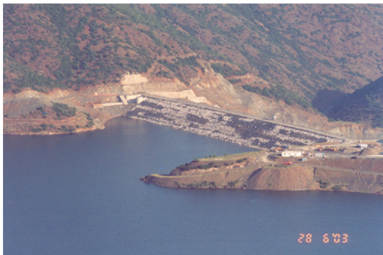
Εικόνα 24: 28/06/2003. Περιοχή φράγματος, πέντε μήνες αργότερα. Ο ταμιευτήρας σχηματίσθηκε μετά τις πολλές βροχές του περασμένου χειμώνα. Στην άκρη του φράγματος φαίνεται η υπερχειλίση.
