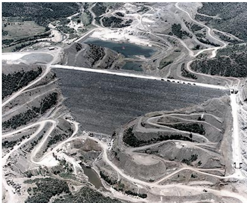
Εικόνα 11: Το φράγμα και μέρος του ταμιευτήρα της τεχνητής λίμνης Σμοκόβου μετά την ολοκλήρωση της κατασκευής τους.
