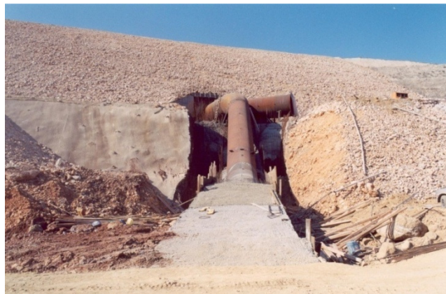
Εικόνα 58: Η έξοδος της κυρίως σήραγγας Λεονταρίου (μεταγενέστερη).
