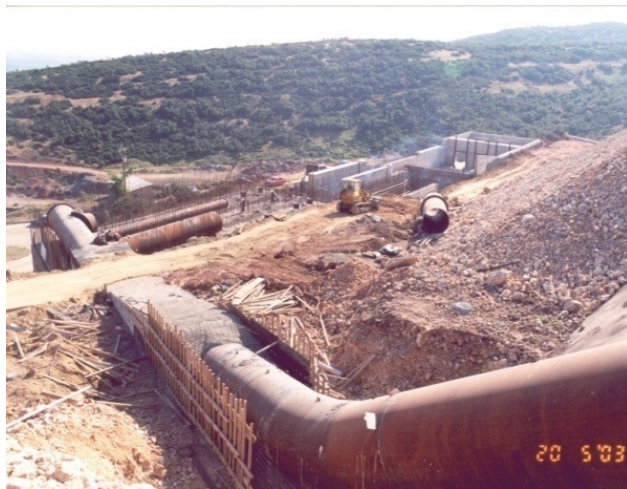
Εικόνα 59: Ο μεταλλικός αγωγός πίεσης \Phi 2,5 m, μήκους 52 m.
