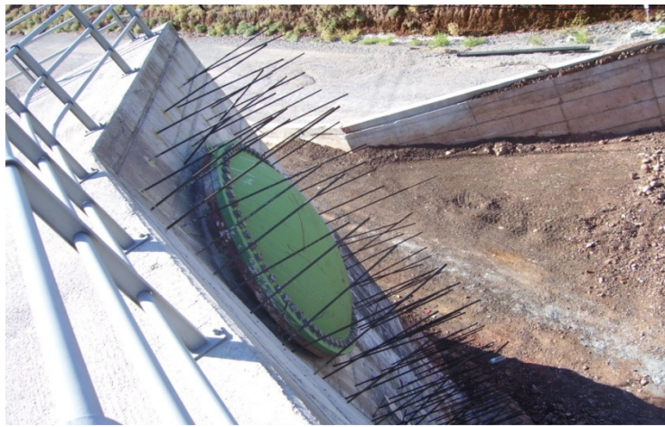
Εικόνα 69: Το σημείο κατάληξης του μεταλλικού αγωγού \Phi 2,5 m
