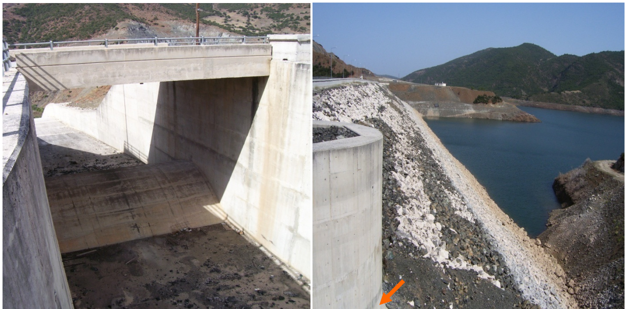
Εικόνα 48: Είσοδος του νερού στον υπερχειλιστή.
