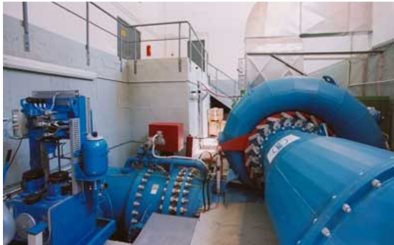
Εικόνα 77: Στρόβιλος Francis οριζώντιου άξονα περιστροφής (εγκατεστημένος)
