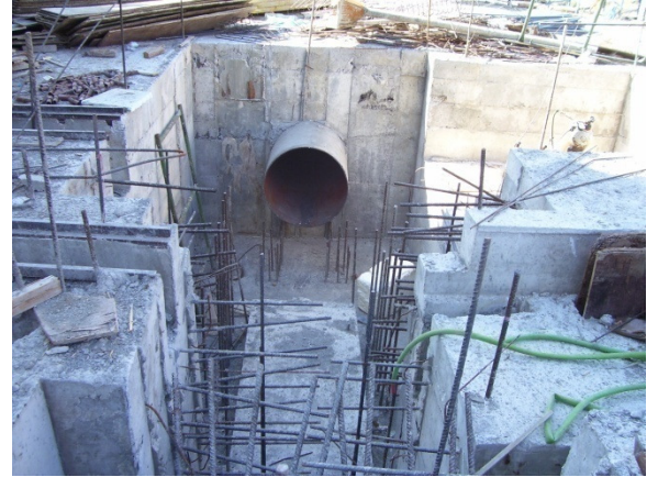
Εικόνες 75 και 76: Αγωγοί αμέσως πριν τους στροβίλους Νο1 και Νο2 αντίστοιχα.
