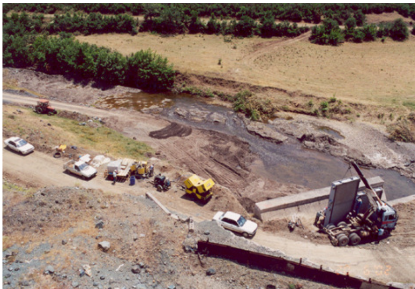
Εικόνα 15: 20/6/2002. Τοποθέτηση των θυροφραγμάτων στη σήραγγα εκτροπής που δημιουργήθηκε για να οδηγεί τα νερά των ποταμών Ρεντινιώτη και Ονόχωνου στον ποταμό Σοφαδίτη, παρακάμπτοντας την περιοχή όπου γινόντουσαν οι εργασίες κατασκευής του φράγματος.
