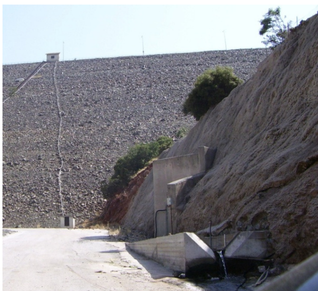
Εικόνα 47: Η συλλογή και απαγωγή των νερών, της τάφρου ορθογώνιας διατομής, από την αποστράγγιση.
