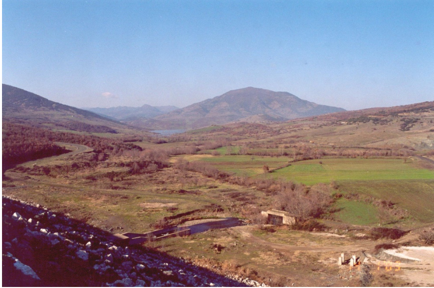
Εικόνα 54: Η γέφυρα Κτιμένης πριν την κατασκευή του αναχώματος προσπέλασης.
