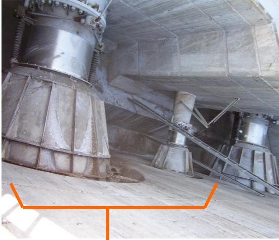
Εικόνες 64 και 65: Ρυθμιζόμενες δικλείδες κοίλης φλέβας
