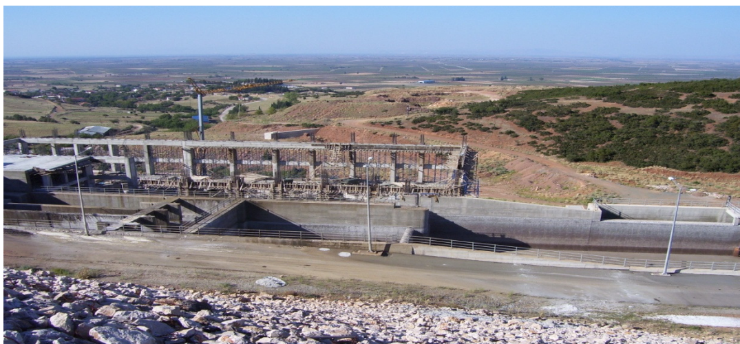
Εικόνα 63: Έργο Καταστροφής Ενέργειας.
