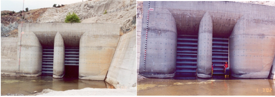
Εικόνες 43 και 44: Η είσοδος της σήραγγας εκτροπής πριν και μετά το κατέβασμα των χαλύβδινων θυρών .
