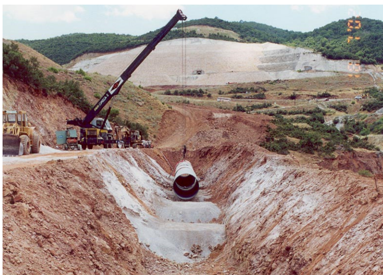
Εικόνα 97: Από την τοποθέτηση του αγωγού Φ 1800 mm.
