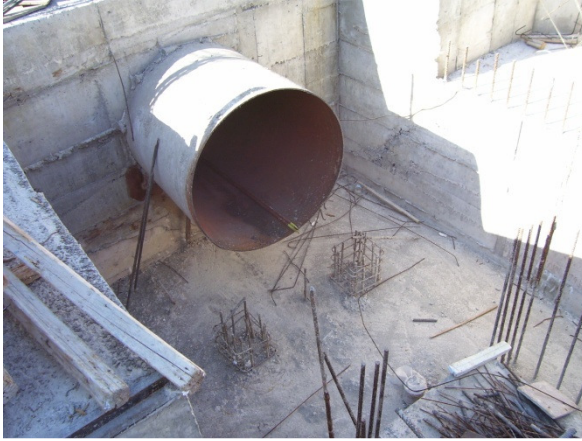
Εικόνες 75 και 76: Αγωγοί αμέσως πριν τους στροβίλους Νο1 και Νο2 αντίστοιχα.
