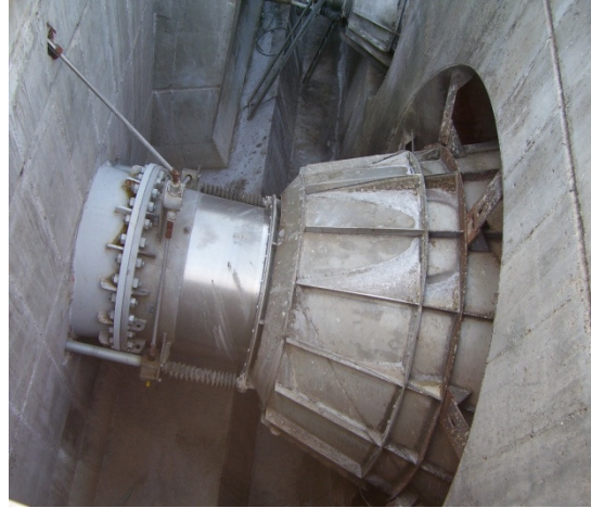
Εικόνες 64 και 65: Ρυθμιζόμενες δικλείδες κοίλης φλέβας
