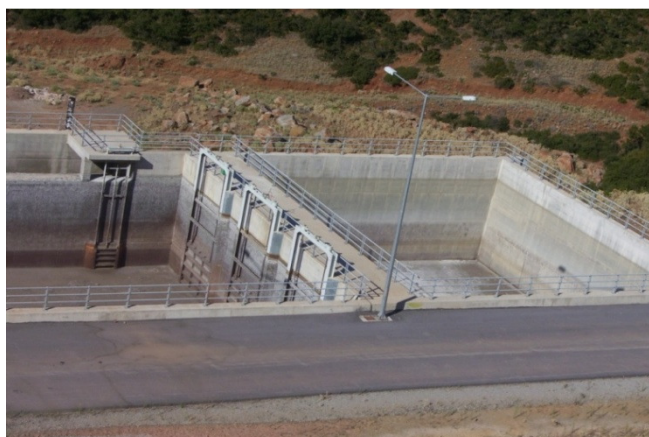
Εικόνα 68: Ο θάλαμος φόρτισης. Διακρίνονται, ο υπερχειλιστής μετρήσεων παροχής και οι τρεις ρυθμιστές εκκένωσης-ελέγχου ολικής παροχής στο καπάντη πέρας του θαλάμου φόρτισης.
