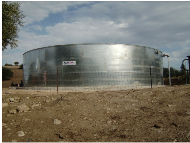
Εικόνα 39. Εγκατάσταση μεταλικής δεξαμενής χωρίς περιμετρική κάλυψη με χώμα
