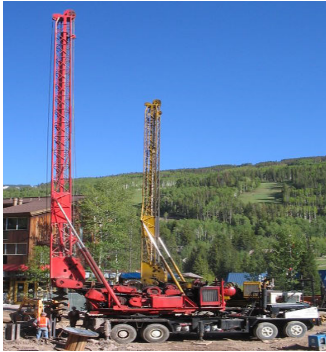
Εικόνα 27. Γεωλόγος κάνει επίβλεψη κατά την διάνοιξη γεώτρησης
