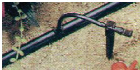
Εικόνα 7.2β: Εγκατάσταση σταλακτών
