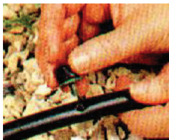
Εικόνα 7.2β: Εγκατάσταση σταλακτών
