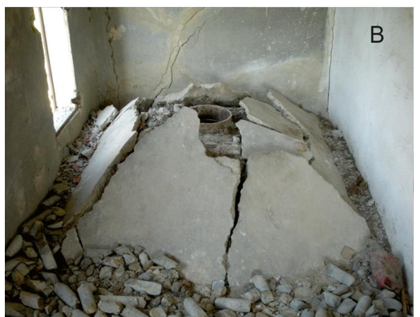
Εικόνα 1.5 - Καταστροφή υδρογεώτρησης.
