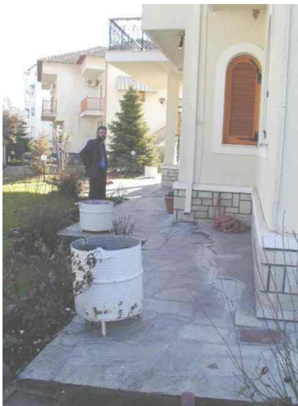
Εικόνα 2.32 - Εμφανή ίχνη της οριακής διάρρηξης των εδαφικών υποχωρήσεων στην περιοχή των Φαρσάλων.
