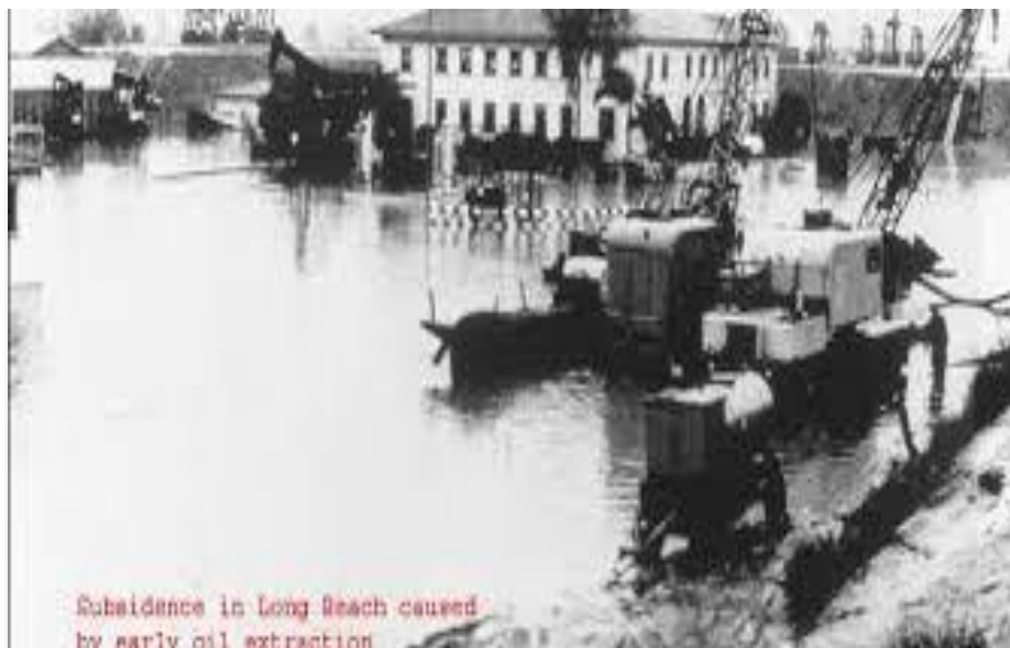
Εικόνα 2.8 - Βύθισμα 9 μέτρα γύρω από το λιμάνι του Long Beach και κατά μήκος της ακτογραμμής της πόλης.
