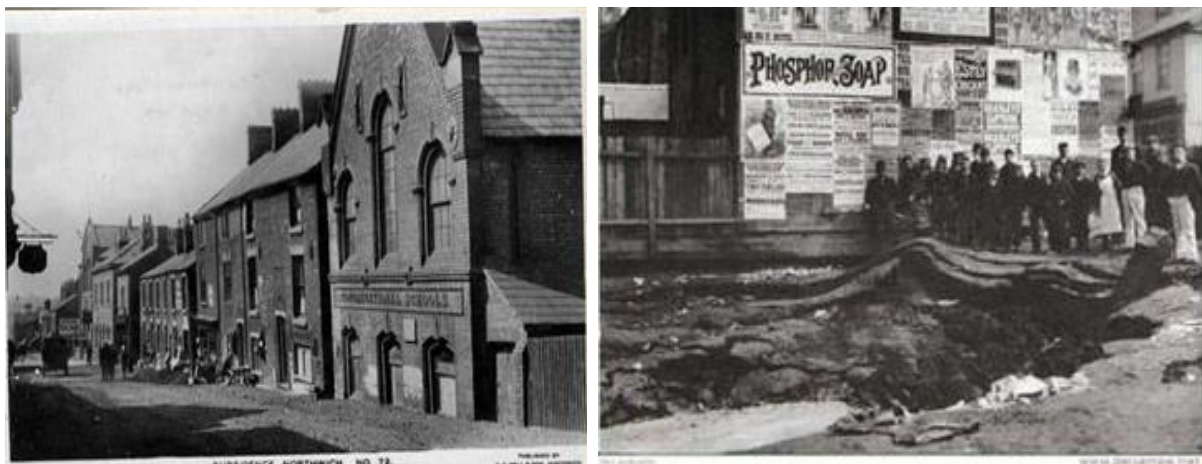
Εικόνα 2.59 Εδαφική υποχώρηση στοών στη πόλη Northwich στο Cheshire ΒΔ Αγγλία.
