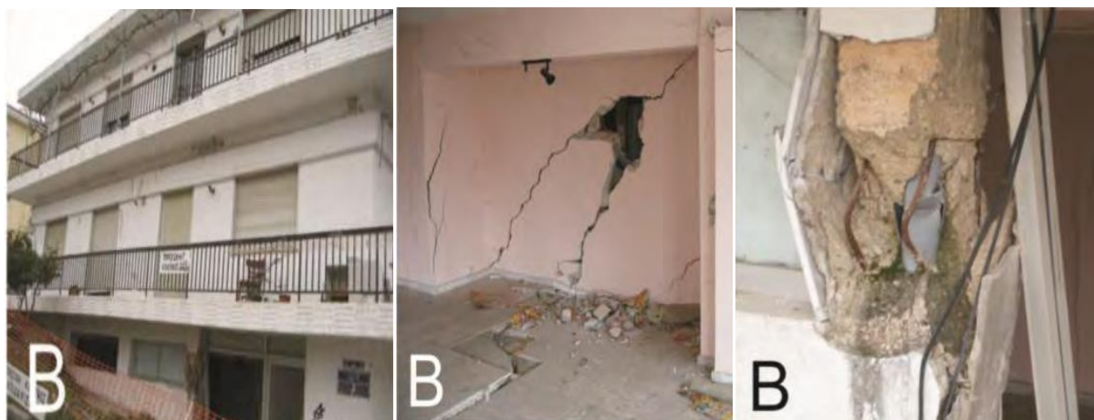
Εικόνα 2.19 - Ίχνη διαρρήξεων των εδαφικών υποχωρήσεων στην περιοχή Περαίας, Ν. Θεσσαλονίκης.
