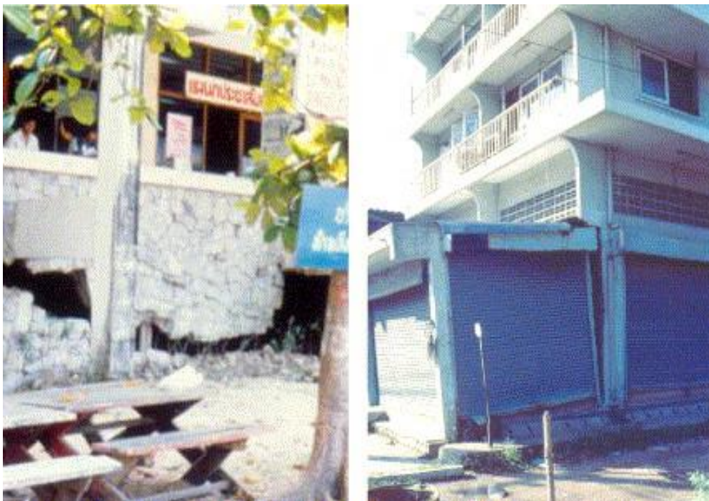
Εικόνα 2.9 - Ζημιές που προκλήθηκαν από εδαφικές υποχωρήσεις του εδάφους στην Μπανγκόκ.
