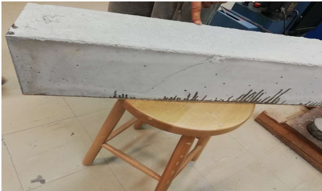
Εικόνα 52. Ρωγμές αστοχίας δοκιμίου 3 μετά την δοκιμή της κάμψης.
