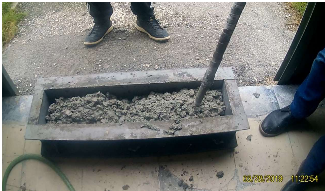
Εικόνα 26. Συμπύκνωση σκυροδέματος με ράβδο
