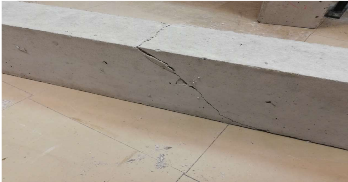
Εικόνα 47. Ρωγμές αστοχίας δοκιμίου 1 μετά την δοκιμή της κάμψης.
