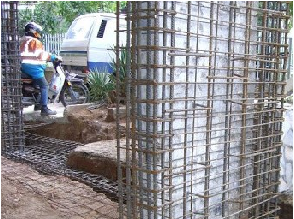
ΕΙΚΟΝΑ 7. Επισκευή με έγχυτο σκυρόδεμα (Επισκευές κτιρίων , Εκτοξευόμενο σκυρόδεμα Gunite , Αμμοβολή)
