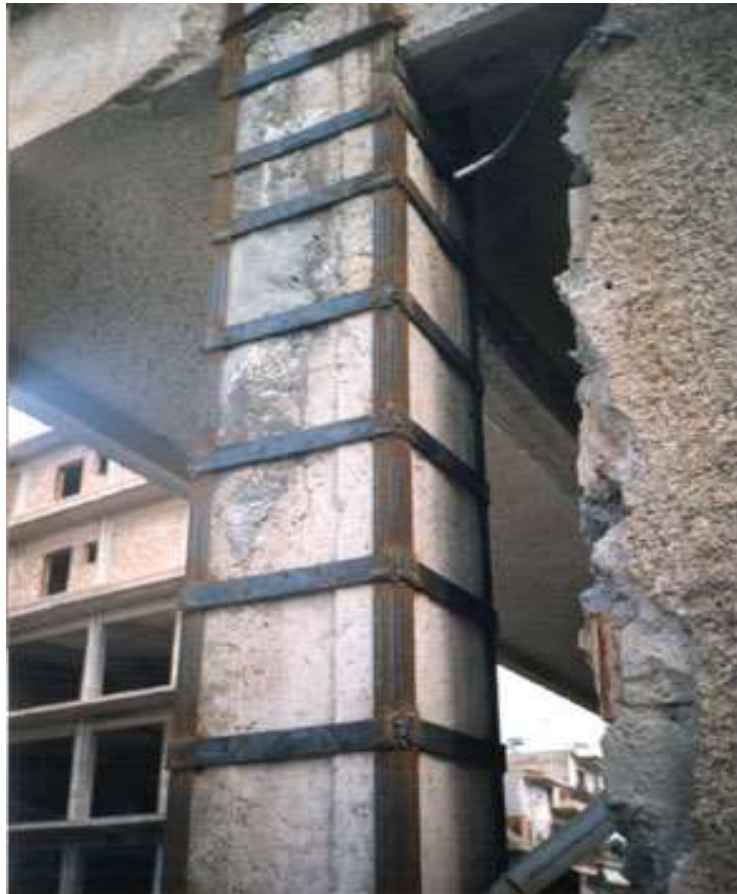
ΕΙΚΟΝΑ 12. Μεταλλικά ελάσματα (ΕΠΙΑΚΕΥΕΣ ΚΑΙ ΕΝΙΣΧΥΣΕΙΣ ΚΑΤΑΣΚΕΥΩΝ ΠΑΝΕΠΙΣΤΗΜΙΟ ΠΑΤΡΩΝ)
