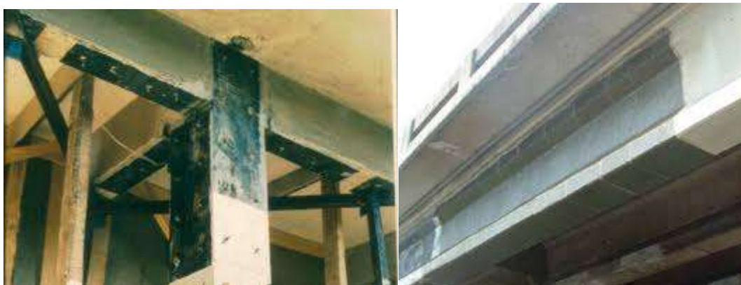
ΕΙΚΟΝΑ 13. Ινοπλισμένα πολυμερή FRP σε μορφή λωρίδων (ΕΝΙΣΧΥΣΗ ΤΩΝ ΚΑΤΑΣΚΕΥΩΝ ΜΕ ΧΡΗΣΗ ΣΥΝΘΕΤΩΝ ΥΛΙΚΩΝ ΑΠΟ ΙΝΟΠΛΙΣΜΕΝΑ ΠΟΛΥΜΕΡΗ ΠΑΠΑΣΕΡΑΦΕΙΜ ΑΝΑΣΤΑΣΙΑ)
