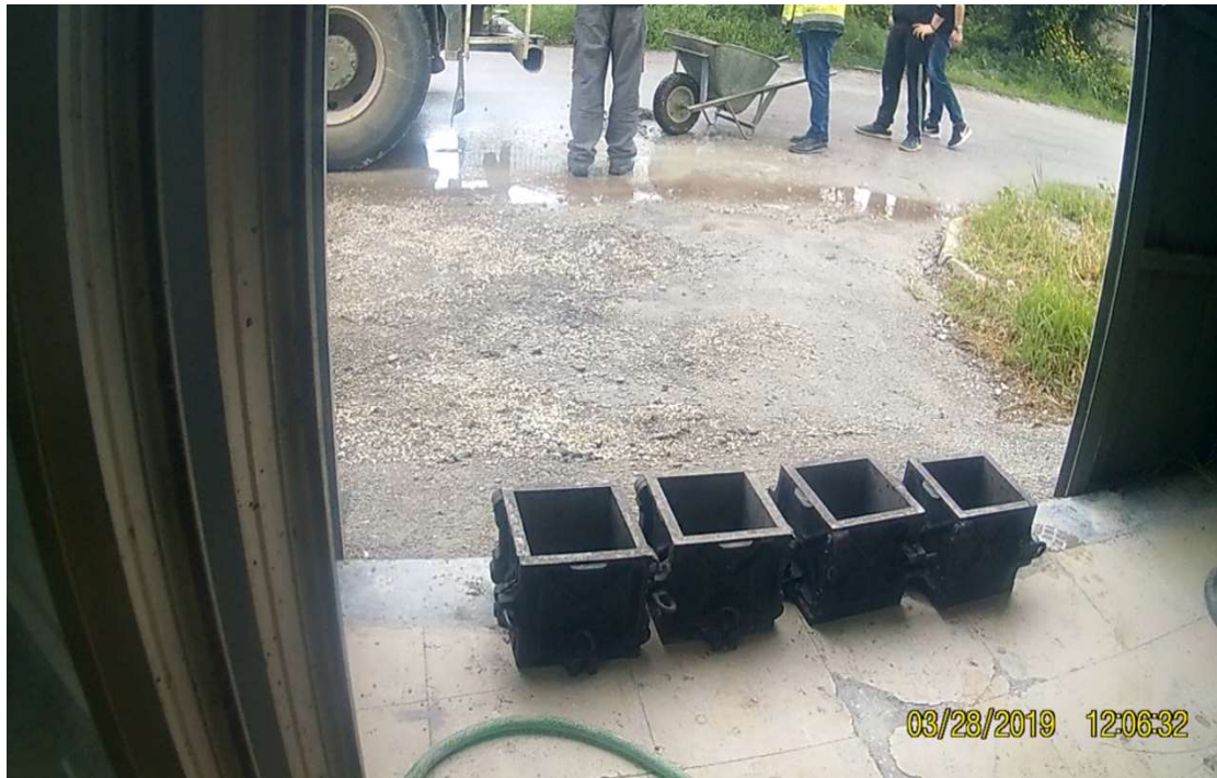
Εικόνα 29α. Σκυροδέτηση τετραγωνικών καλουπιών
