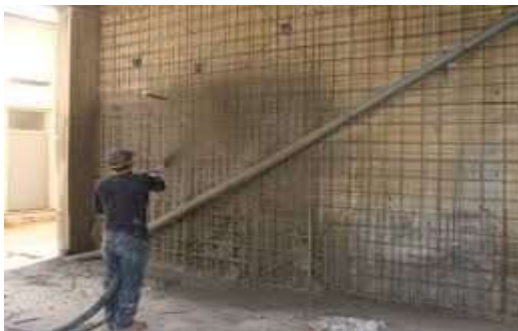
ΕΙΚΟΝΑ 8. Επισκευή με εκτοξευόμενο σκυρόδεμα (ΓΚΑΝΑΪΤ-HELLAS)
