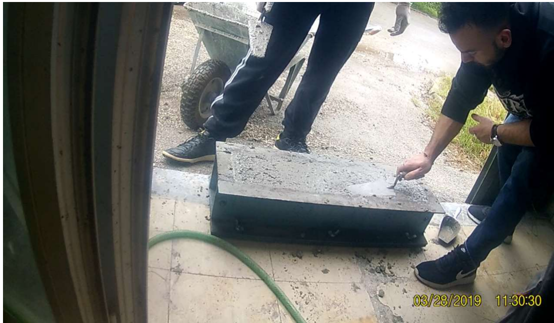
Εικόνα 27. Επιπεδοποίηση σκυροδέματος
