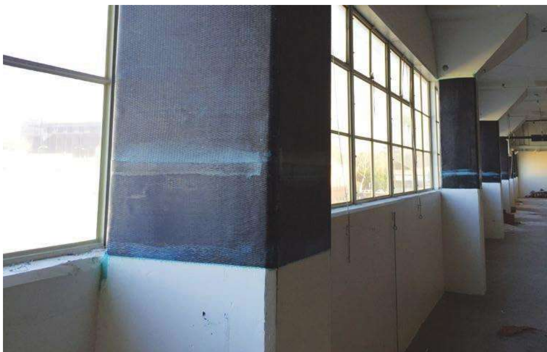
ΕΙΚΟΝΑ 14. Ινοπλισμένα πολυμερή FRP σε μορφή ολόσωμου μανδύα(ΕΝΙΣΧΥΣΗ ΔΟΜΙΚΩΝ ΣΤΟΙΧΕΙΩΝ ΟΠΛΙΣΜΕΝΟΥ ΣΚΥΡΟΔΕΜΑΤΟΣ ΣΤΙΣ ΑΝΑΚΑΙΝΙΣΕΙΣ ΣΥΝΘΕΤΑ ΥΛΙΚΑ & ΕΦΑΡΜΟΓΕΣ)
