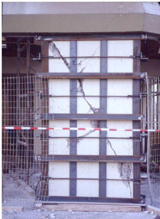
Εικόνα 12. Επέμβαση με μεταλλικό κλωβό για προσωρινή ανάληψη κατακόρυφων φορτίων (ΕΠΙΣΚΕΥΕΣ ΚΑΙ ΕΝΙΣΧΥΣΕΙΣ από οπλισμένο σκυρόδεμα , Στέφανος Η. Δρίτσος)
