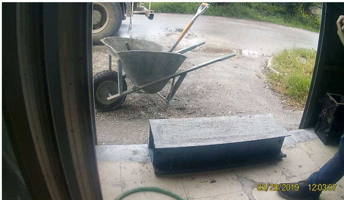
Εικόνα 28. Τελική μορφή διαστρωμένου με σκυρόδεμα καλουπιού
