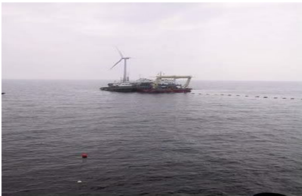
Εγκατάσταση καλωδίων σύνδεσης και προστατευτικών σημαντήρων
