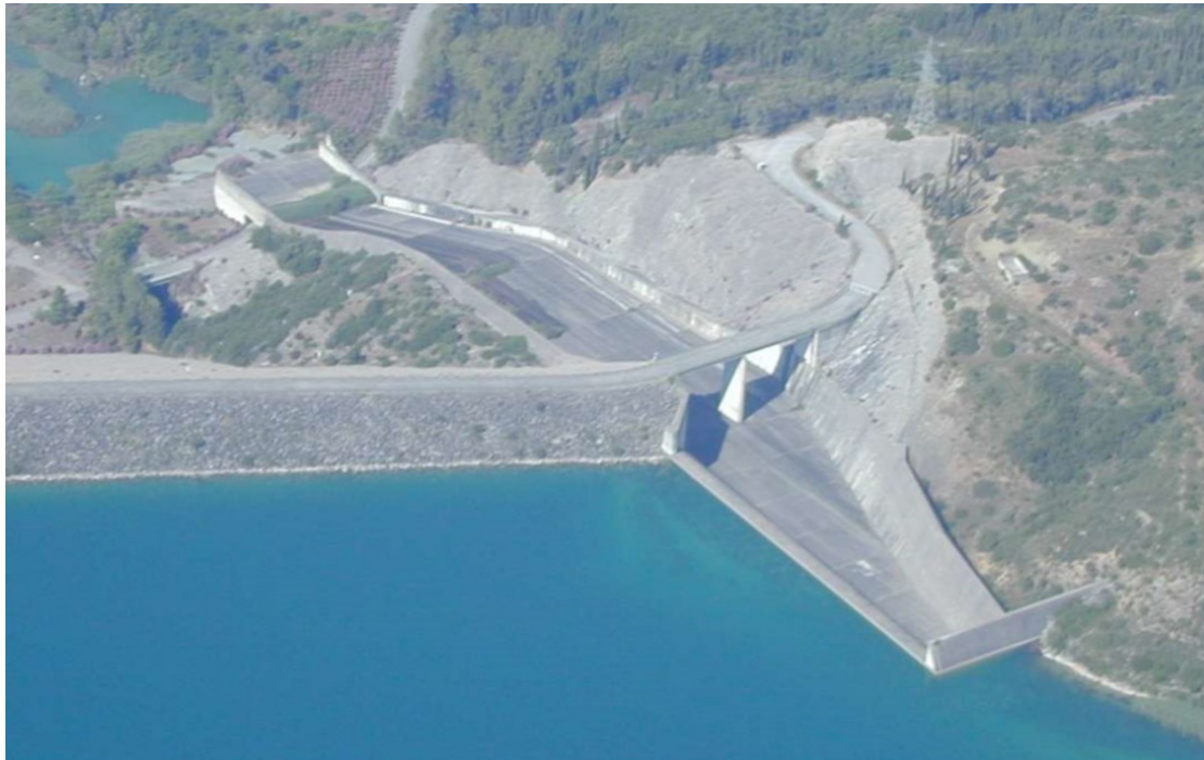
Εικόνα 4.3: Πλευρικός Υπερχειλιστής, Φράγμα Καστρακίου (πηγή: Σχολή Πολιτικών Μηχανικών, Εθνικό Μετσόβιο Πολυτεχνείο)
