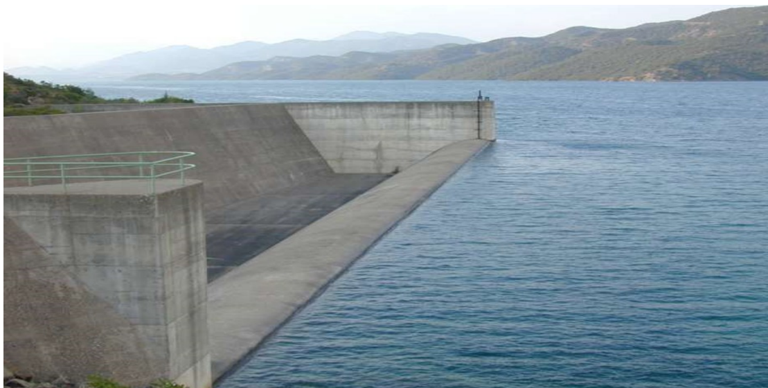
Εικόνα 4.2: Πλευρικός Υπερχειλιστής, Φράγμα Καστρακίου (πηγή: Σχολή Πολιτικών Μηχανικών, Εθνικό Μετσόβιο Πολυτεχνείο)
