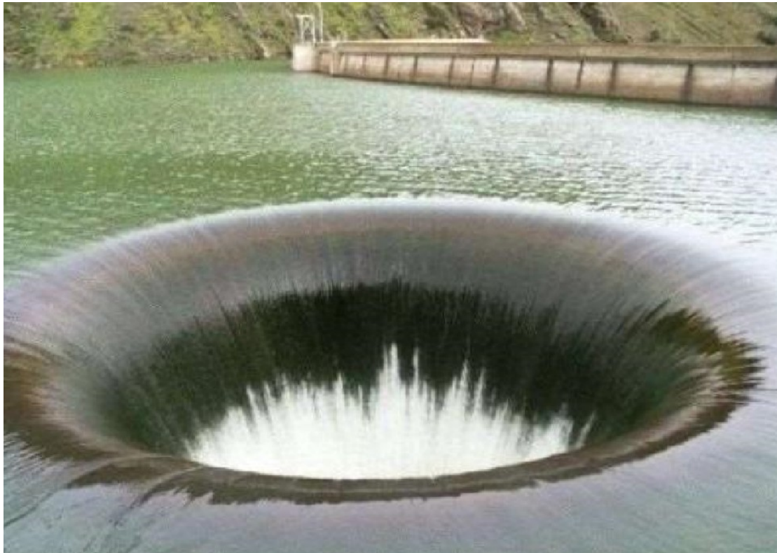
Εικόνα 4.4: Φρεατοειδής υπερχειλιστής (πηγή: Σχολή Πολιτικών Μηχανικών, Εθνικό Μετσόβιο Πολυτεχνείο)
