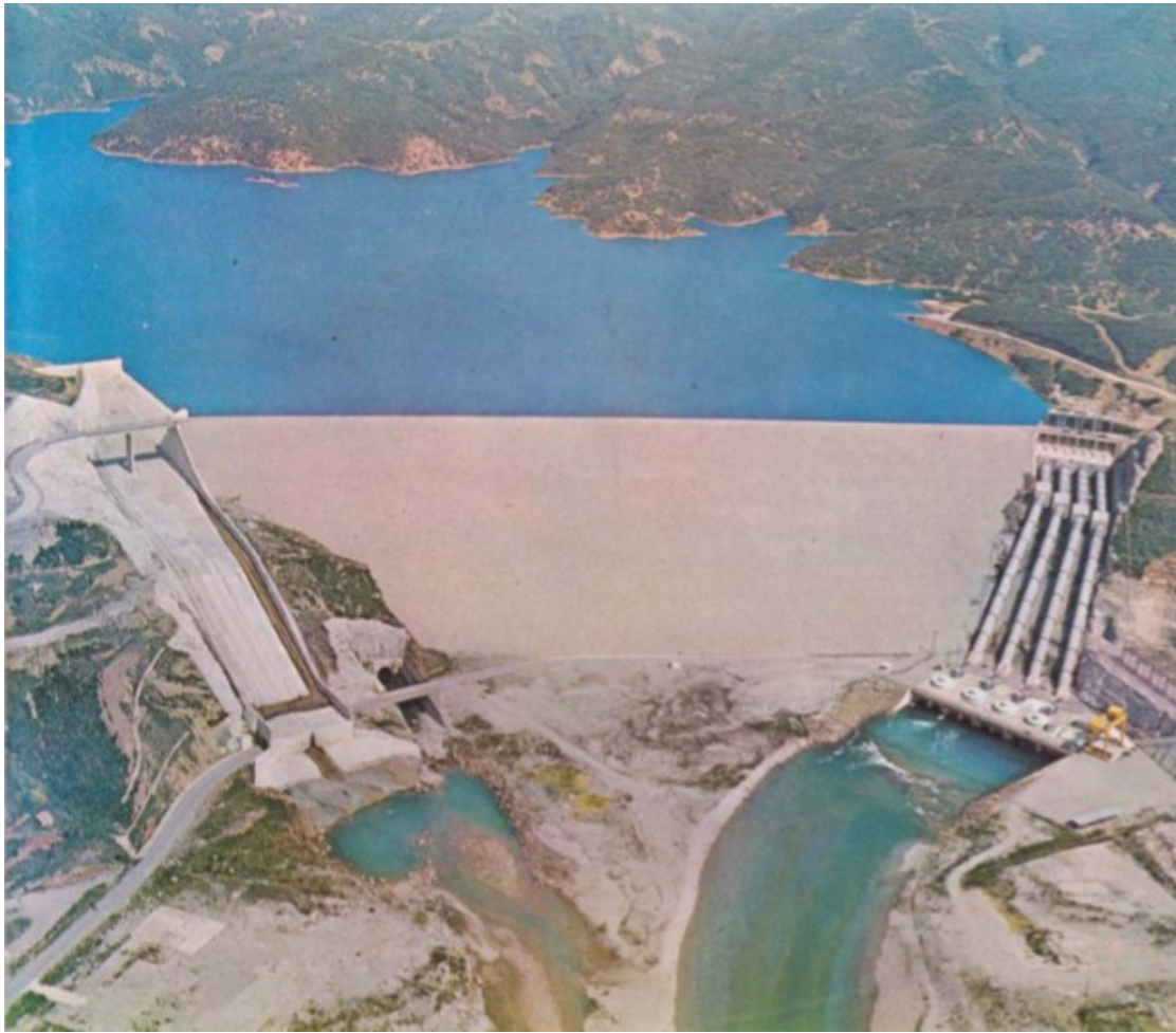
Εικόνα 3.3: Φράγμα Καστρακίου, Αιτωλοακαρνανία (πηγή: Ελληνική Επιτροπή Μεγάλων Φραγμάτων)
