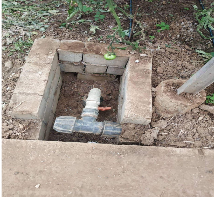
ΕΙΚΟΝΑ 14 ΥΔΡΟΛΗΨΙΑ ΕΝΤΟΣ ΤΟΥ ΘΕΡΜΟΚΗΠΙΟΥ
