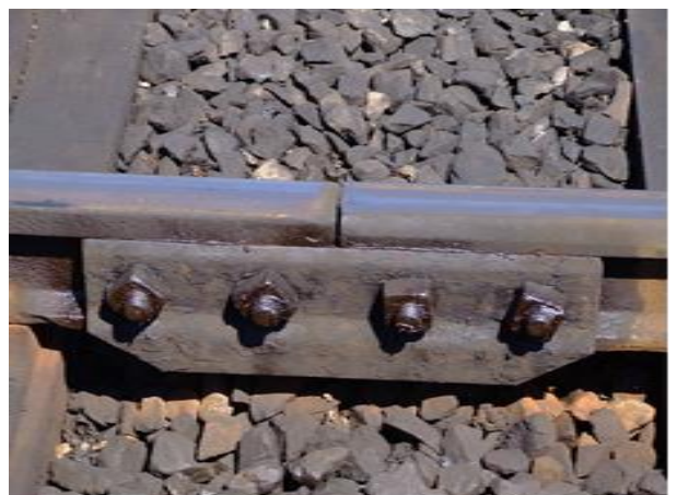
Σχ. 2.22 (α) Σύνδεση σιδηροτροχιάς – στρωτήρα (β) Αμφιδέτης σιδηροτροχιάς[5]
