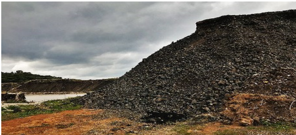
Εικόνα 12: Λόφοι από σκουριές (κατάλοιπα, μεταλλευτικά απορρίμματα) με μεγάλη τοξικότητα. Γύρω από αυτούς έχουν οικοδομηθεί οικισμοί
