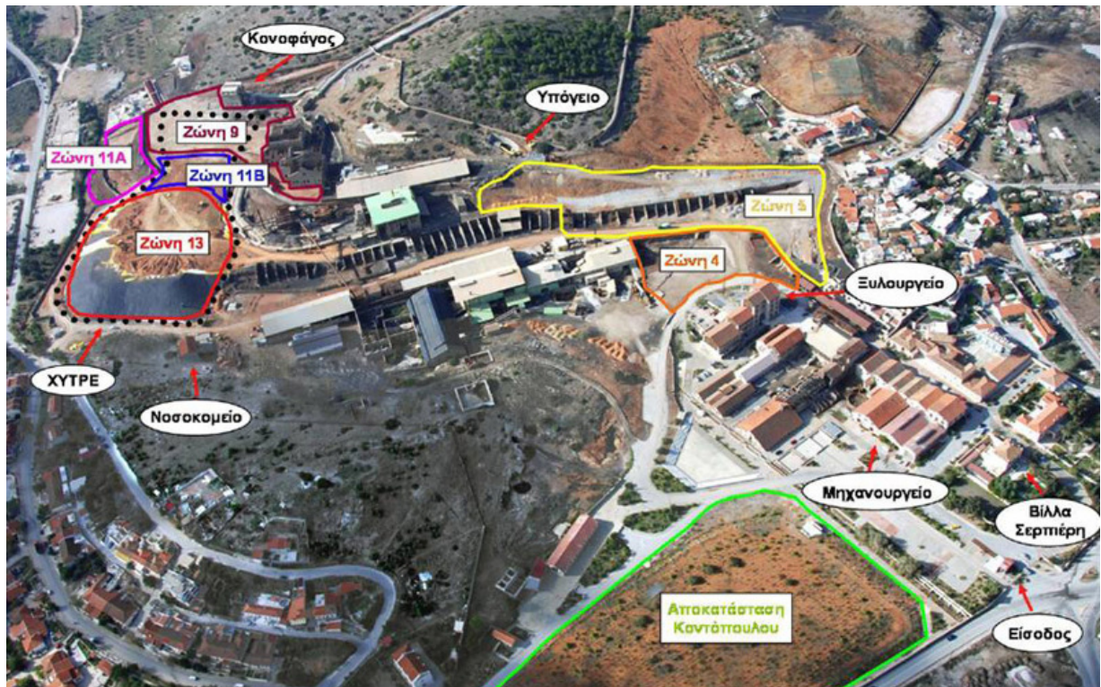
Εικόνα 16: Θέση των περιοχών εκσκαφής και του Χώρου Υγειονομικής Ταφής Ρυπασμένων Εδαφών
