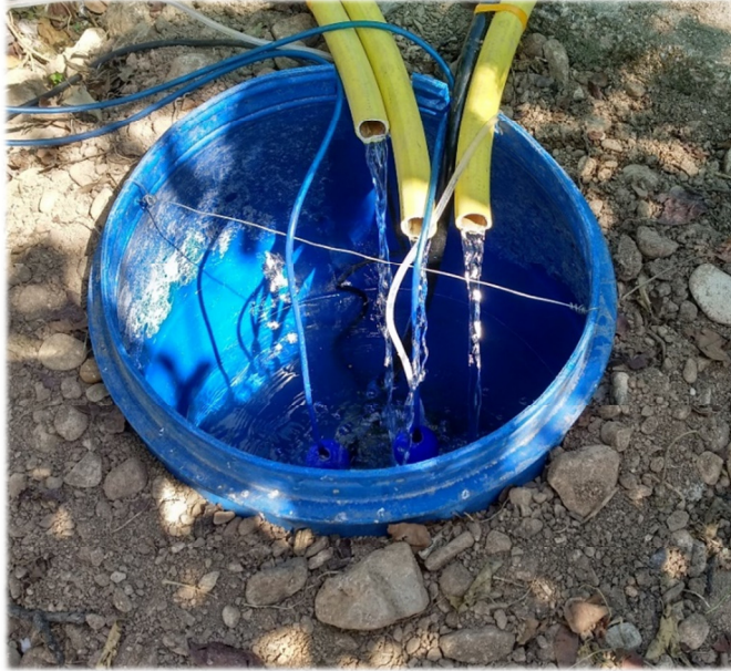
Εικόνα 4.7: Υπόγεια δεξαμενή χωρητικότητας 130 λίτρων.
