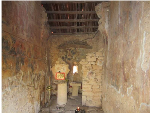
4.17 Εσωτερική όψη του ναού Παύλιτσας. (GOOGLE IMAGE)
