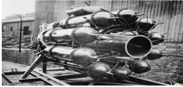
Σχήμα 1.19: Ο πρώτος αεριοστρόβιλος Whittle W1 που σώζεται και είναι σε θέση να λειτουργεί έως σήμερα στο Grandfield University, U.K.
