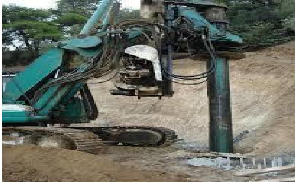
Εικόνα 2.5 πασσαλομηχάνημα διάτρηση πασσάλων
