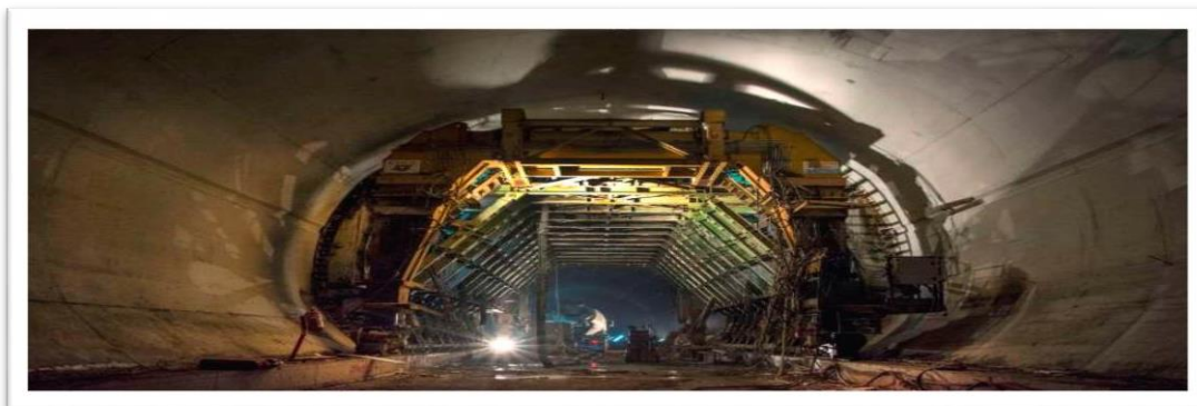
Εικόνα 1.10μεταλλότυπος(καλούπι) για σκυροδέτηση θόλου σήραγγας
