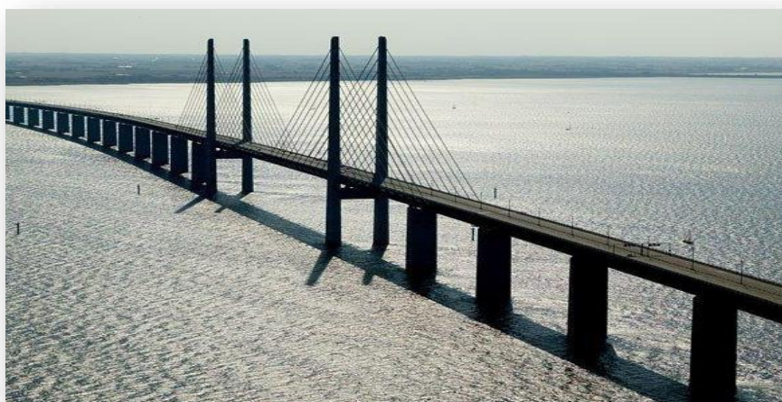
Εικόνα 1.28 Σουηδία – Δανία οδική γέφυρα-τεχνητό νησί προς υπόγεια σήραγγα
