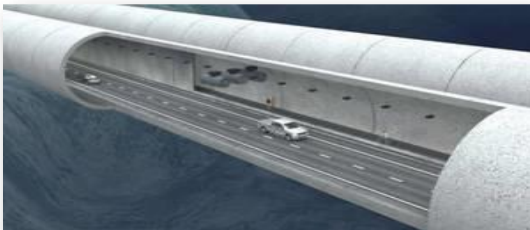
Εικόνα 1.23 Υποθαλάσσιοι γιγάντιοι σωλήνες θα αιωρούνται σε βάθος 30 m
