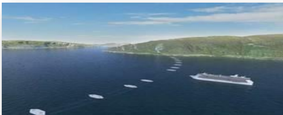
Εικόνα 1.23 Υποθαλάσσιοι γιγάντιοι σωλήνες θα αιωρούνται σε βάθος 30 m
