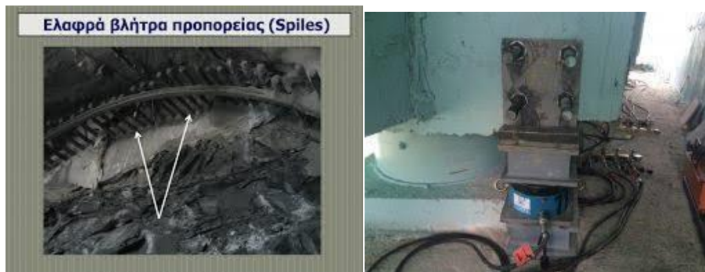
Εικόνα 2.16ελαφρά βλήτρα προπορείας (spiles)Εικόνα 2.17βλητρώσεις -αγκυρώσεις
