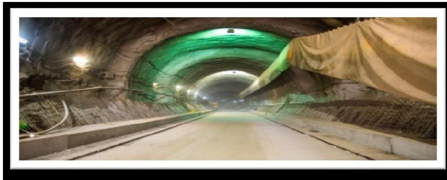
Εικόνα 1.11 Πελοπόννησος Ροδοδάφνη- Ψαθόπυργος στάδια έργου
