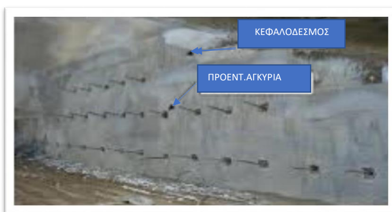
Εικόνα 2.4πασσαλοτοιχία με προεντεταμένα αγκύρια-κεφαλόδεσμος
