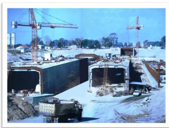
Εικόνα 1.6 Κατασκευή Στοιχείων σήραγγας
