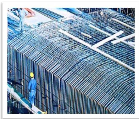
Εικόνα 1.4 οπλισμός σκυροδέτησης στοιχείων σήραγγας Εικόνα 1.5 υποθαλάσσια σήραγγα Ακτίου-Πρέβεζας με τις τουρμπίνες εξ αερισμού σήραγγας
