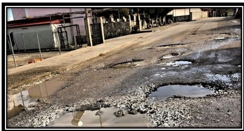
Εικόνα 2: Αποκόλληση αδρανών οδοστρώματος
