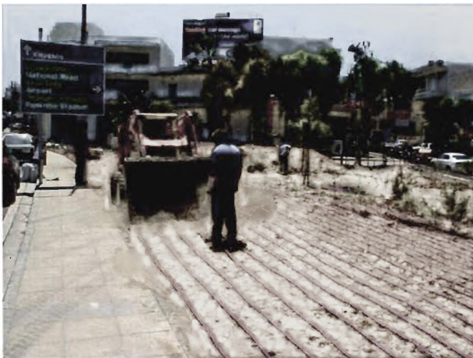
Εικόνα 3 Επιχωμάτωση σε είδη εγκατεστημένους σωλήνες.
