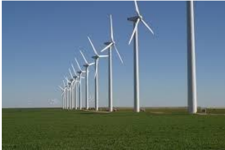
Εικόνα 2.37.: Ανεμοκινητήρες σε αιολικό πάρκο 67
