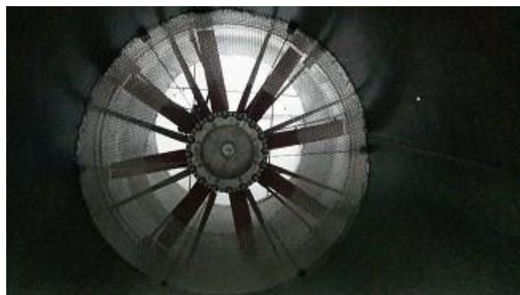
Εικόνα 2.26.: Αξονικός ανεμιστήρας με πλέγμα εξομάλυνσης της ροής σε υποχητική αεροσήραγγα
