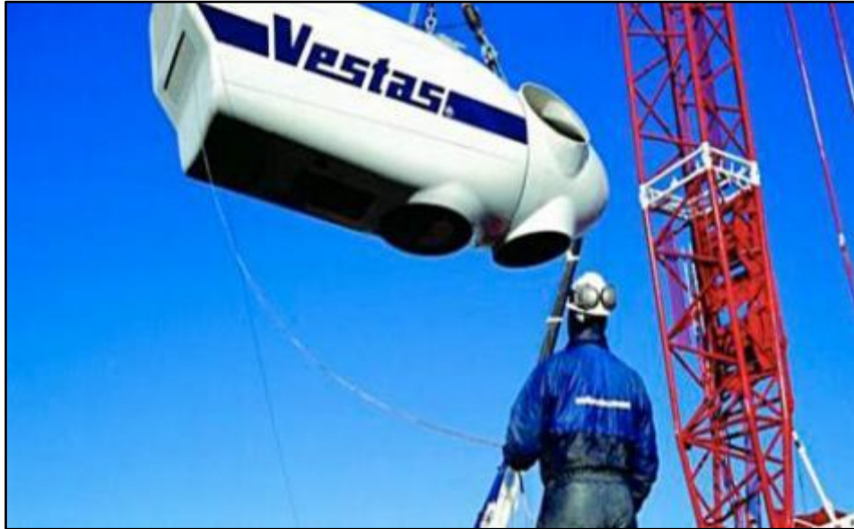
Εικόνα 10. Άτρακτος ανεμογεννήτριας
