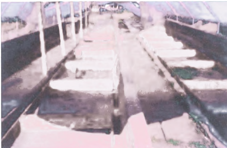
Εικόνα 21 Κατασκευή δεξαμενών πριν τη τοποθέτηση του πλαστικού
