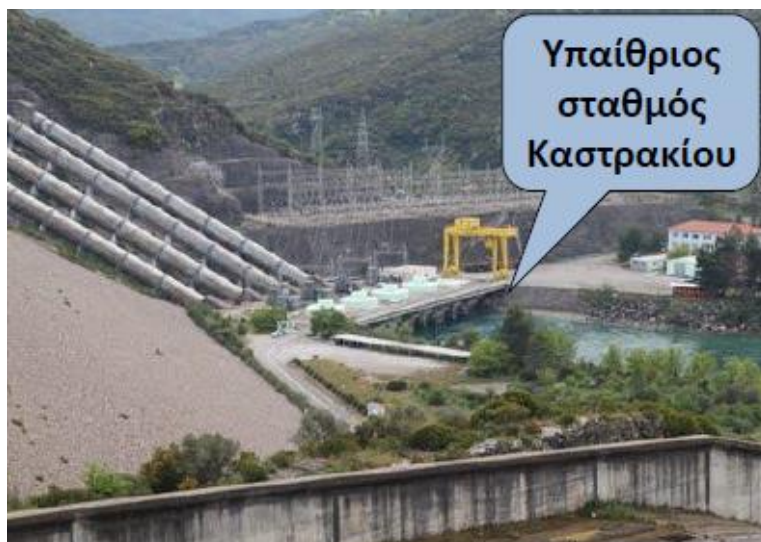
Εικόνα 3.22: Υπαίθριος σταθμός Καστρακίου.
