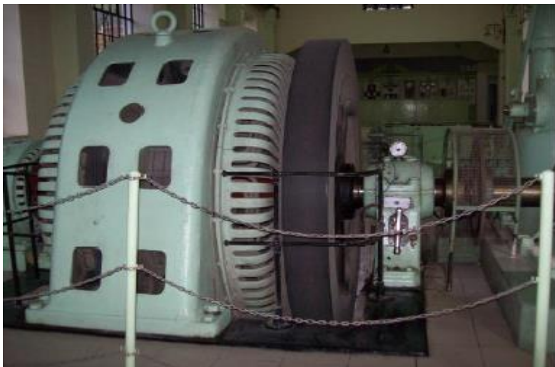
Εικόνα 4.17: Γεννήτρια Pelton.
