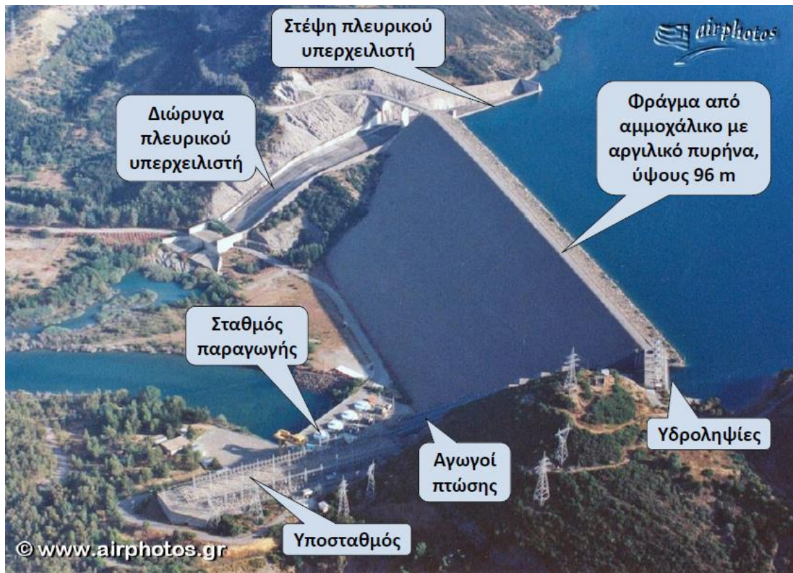
Εικόνα 3.15: Υδροηλεκτρικό έργο Καστρακίου.
