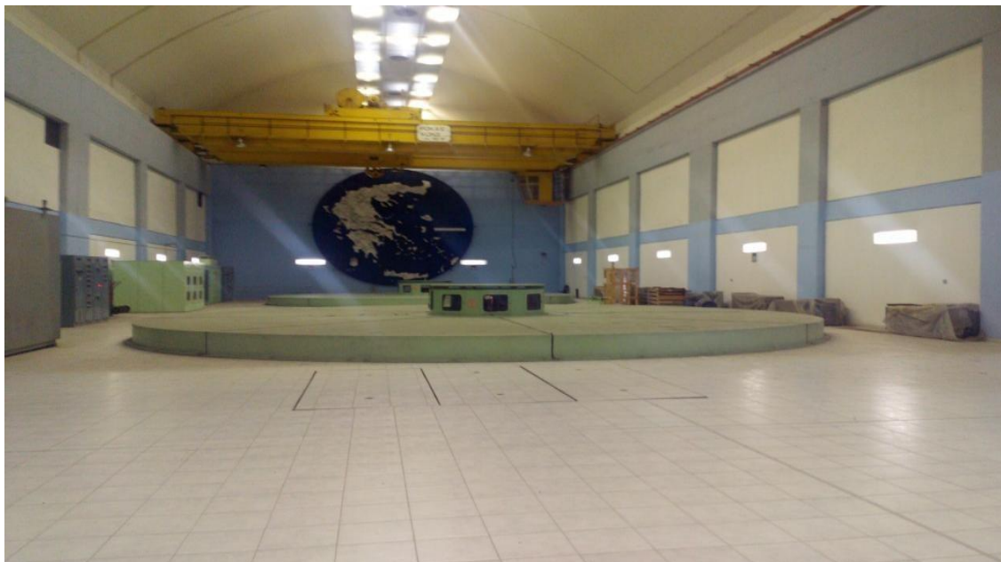
Εικόνα 4.23: Υπόγειος σταθμός παραγωγής.
