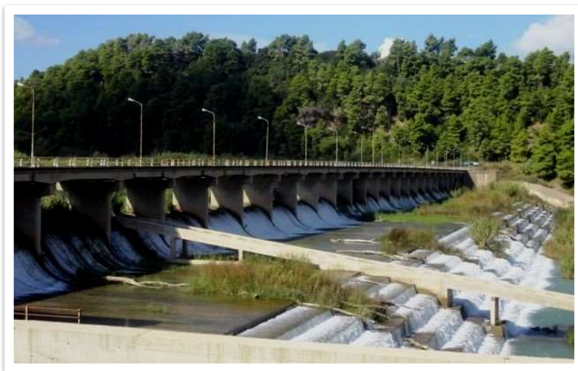
Εικόνα 1.8: Ο υπερχειλιστής (θυρόφραγμα) στον ποταμό Αλφειό στην Ηλεία. (Προσωπικό αρχείο)
