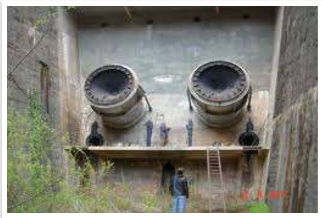
Εικόνα 1.9: Εκκενωτές πυθμένα στο φράγμα Ταυρωπού. (Διαδίκτυο)
