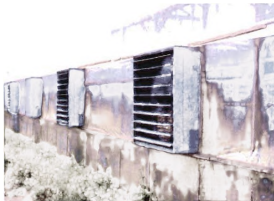
Εικόνα 2. Δυναμικός εξαερισμός θερμοκηπίου
