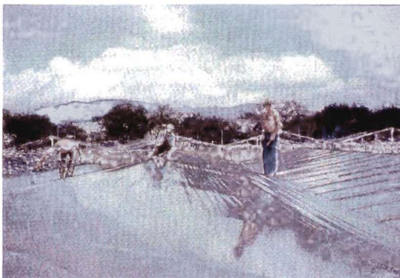
Εικ. 14. Τοποθέτηση πλαστικού φύλλου πολυαιθυλενίου στην οροφή του θερμοκηπίου
