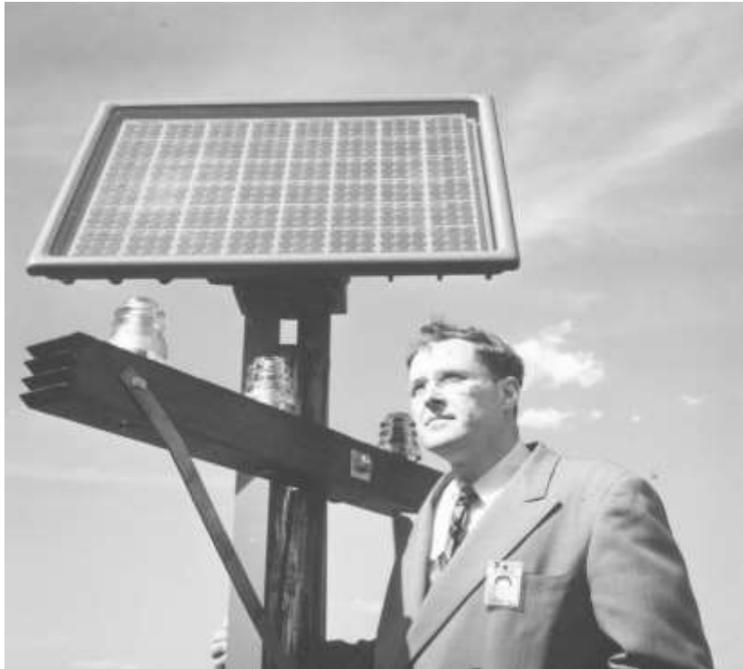
Εικ. 1.9: Το πρώτο φωτοβολταϊκό πλαίσιο από την Bell, εδώ βλέπουμε τα στοιχεία και του δίσκους πυριτίου μέσα στο κάθε ένα. Το πλαίσιο είναι τοποθετημένο σε τηλεφωνικό στύλο.
