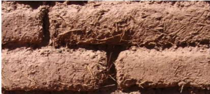
Εικόνα 1.1 : Λεπτομέρεια από κτίσμα. Διακρίνονται τα πλέγματα από το άχυρο μέσα στο τούβλο από πηλό 1
