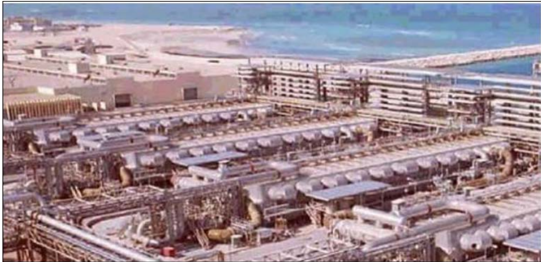
Εικόνα 11: 1 Εγκατάσταση MSF στη Σαουδική Αραβία
