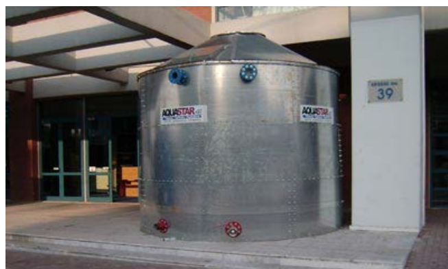
Εικόνα 28: Κυλινδρική μεταλλική νερού με σάκο στεγανοποίησης
