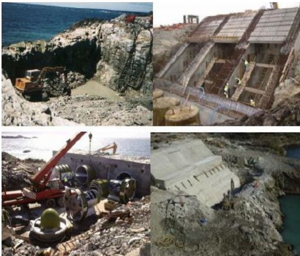
Εικόνα 57: Διαδικασίες – στάδια κατασκευής της διάταξης LIMPET.
