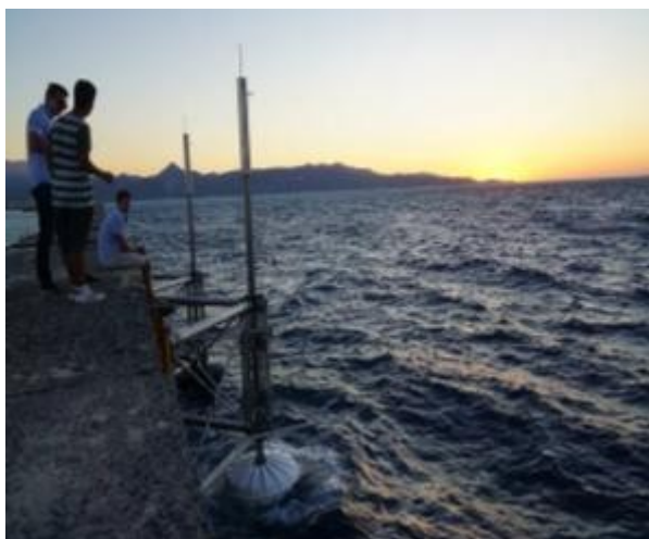
Εικόνα 100: Η διαδικασία της τοποθέτησης δομοστοιχείων μετατροπής κυματικής ενέργειας.
