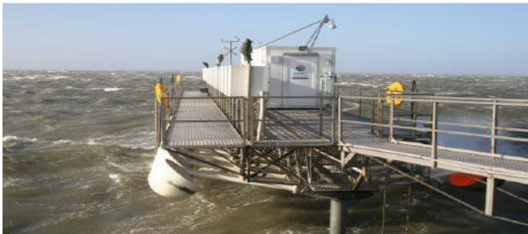
Εικόνα 90: Εγκατάσταση διάταξης WaveStar.
