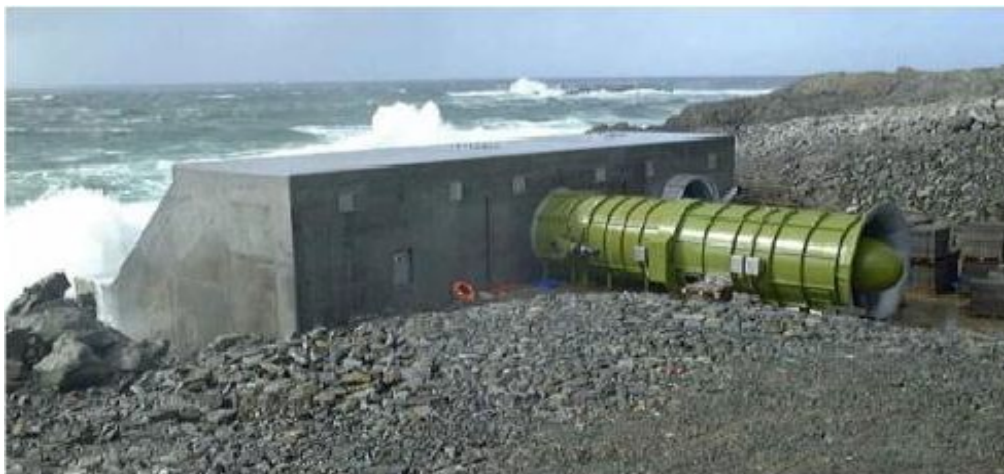
Εικόνα 55: Η εγκατάσταση LIMPET (Σκωτία).
