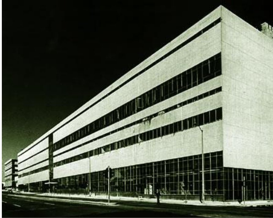
Τάκης Ζενέτος, Εργοστάσιο ΦΙΕ, 1961, πηγή: Google
