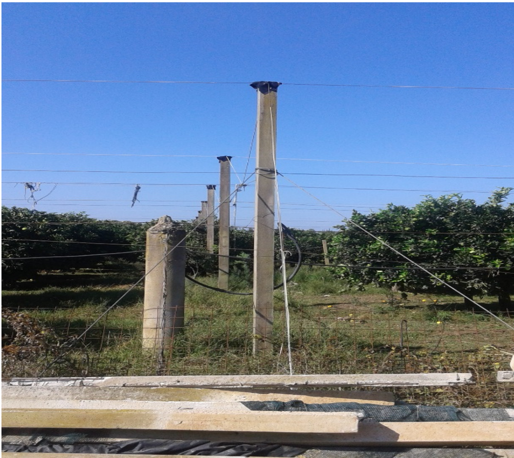
Εικόνα 3.11:Οι πλαϊνές κολώνες δένονται από 3 διαφορετικά σημεία
