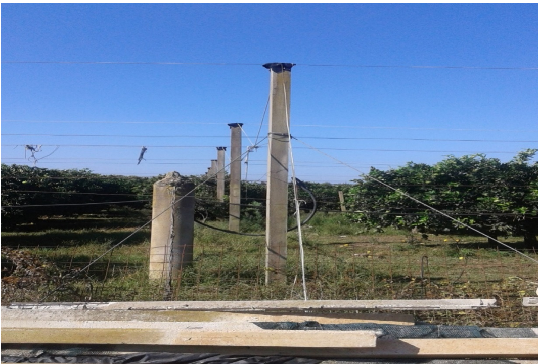
Εικόνα 3.6:Κολώνες τοποθετούνται ευθεία στη σειρά
