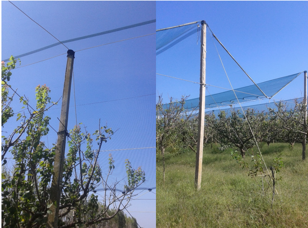
Εικόνα 3.8: Τοποθέτηση οριζόντιου συρματόσκιου στης κολώνες
