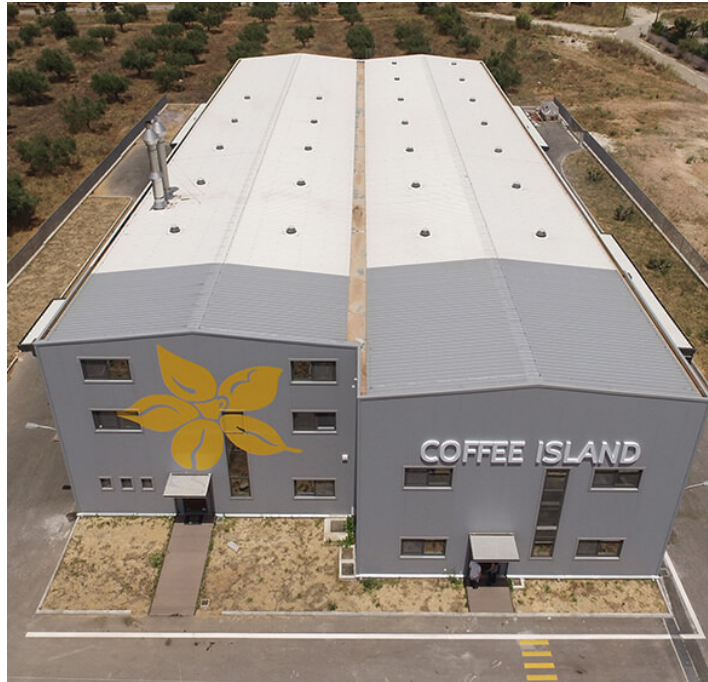
Εικόνα 2.2: Εγκαταστάσεις αποθήκης της εταιρείας Coffee Island.
