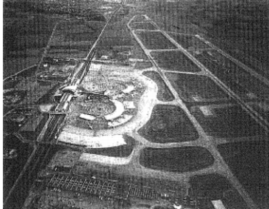
Σχήμα 4.5: Σιδηροδρομικός σταθμός υψηλής ταχύτητας που βρίσκεται εντός του αερολιμένα LyonSatolas.
