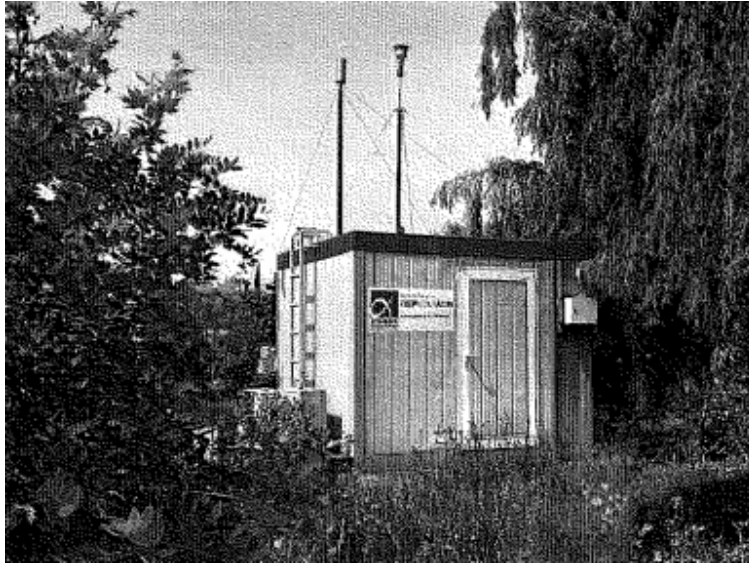
Σχήμα 6.3: Ο Διεθνής Αερολιμένας Αθηνών "Ελ. Βενιζέλος" είναι ένα από τα καλύτερα εξοπλισμένα αεροδρόμια του κόσμου, όσον αφορά στην παρακολούθηση της ποιότητας του αέρα και των μετεωρολογικών συνθηκών
