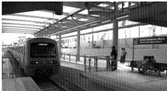
Σχήμα 4.4: Η σιδηροδρομική σύνδεση με το Διεθνή Αερολιμένα Αθηνών "Ελ. Βενιζέλος" κατέστησε ευκολότερη και ταχύτερη την πρόσβαση των επιβατών στο αεροδρόμιο.
