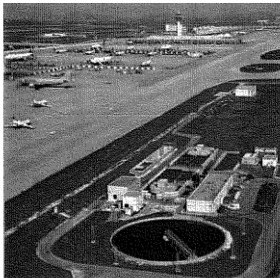
Σχήμα 6.5: Ο Διεθνής Αερολιμένας Αθηνών "Ελ. Βενιζέλος" είναι ένα από τα λίγα αεροδρόμια παγκοσμίως που διαθέτει δικιά του μονάδα διαχείρισης αποβλήτων
