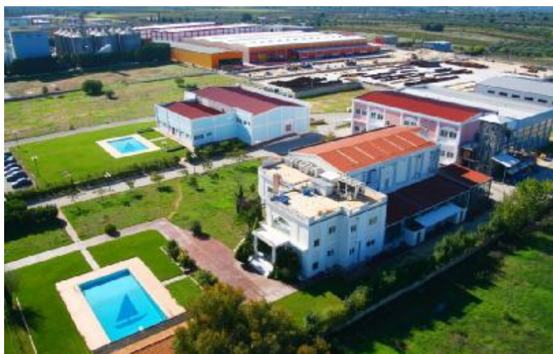
Εικόνα 9: Κτιριακές εγκαταστάσεις Chemical and Biopharmaceutical Laboratories [28]
